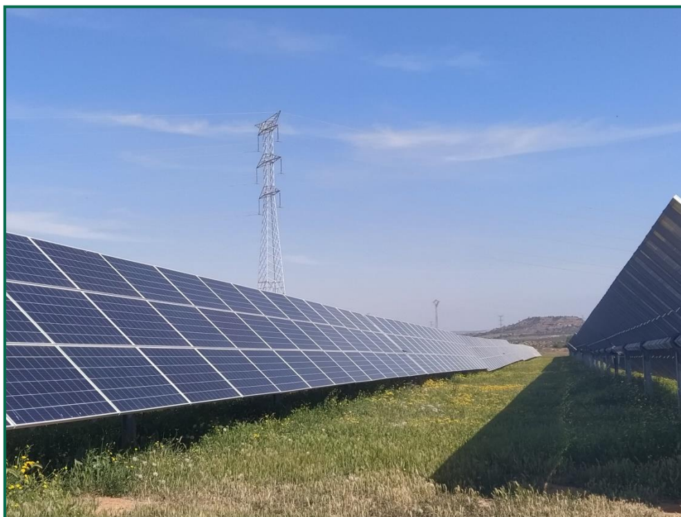
Fotografía 1. Vegetación entre placas actualmente.
