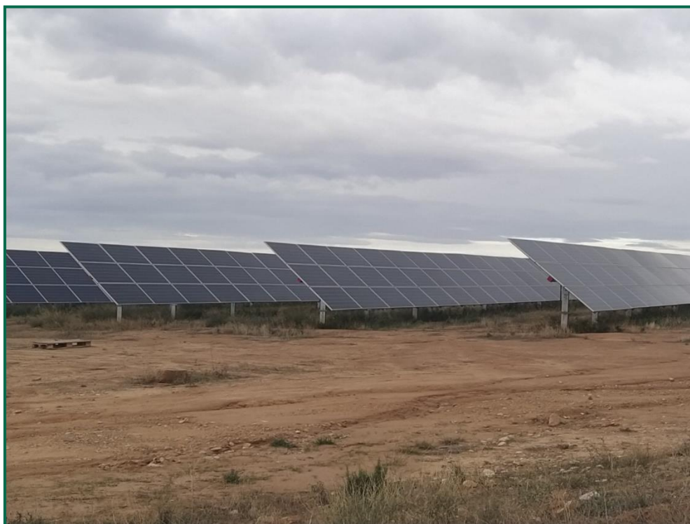
Fotografía 1. Vegetación entre placas actualmente.
