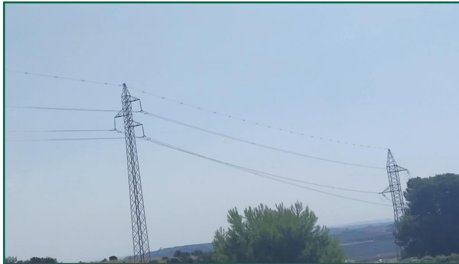
Fotografía 3. Línea eléctrica con balizas salvapájaros
