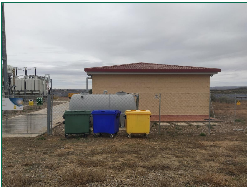
Fotografía 8. Contenedores de residuos no peligrosos en exterior de la subestación.
