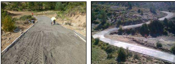
Fase de colocación de mallazo de acero corrugado y pavimentación en hormigón una vez finalizados los trabajos.
