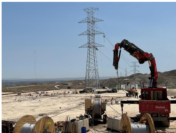
Figura 4 Tirada de cable de alta tensión Ap. 42-Ap. 36
