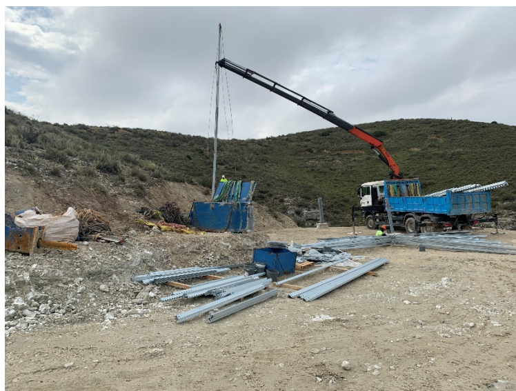
Figura 4 Montaje de la estructura
