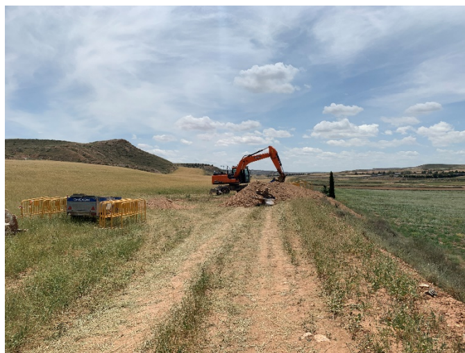
Figura 2 Excavación de los cimientos del apoyo
