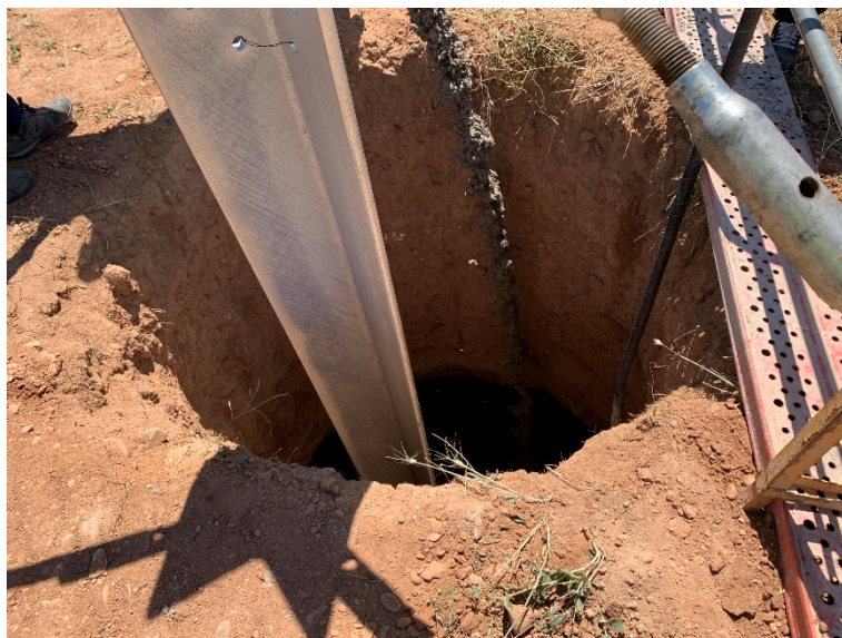
Figura 3 Cimentación de los apoyos
