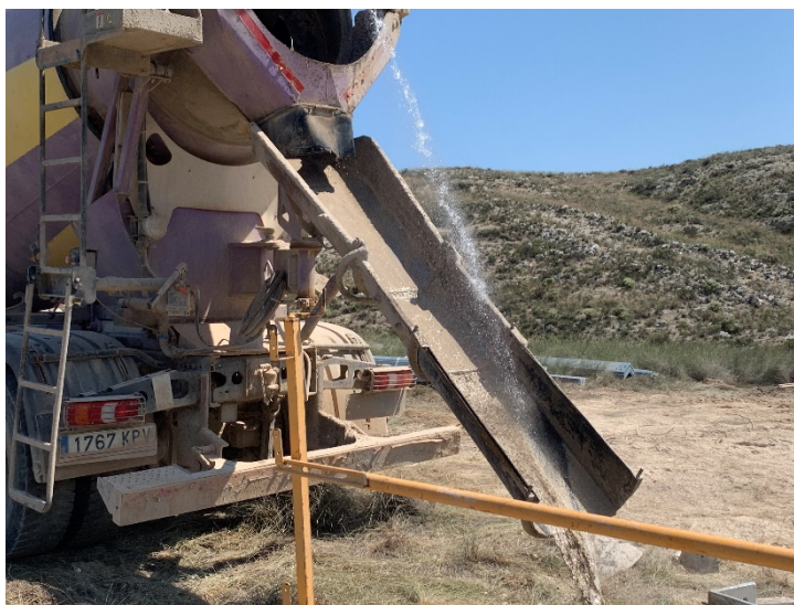
Figura 5 Limpieza de cuba de hormigón
