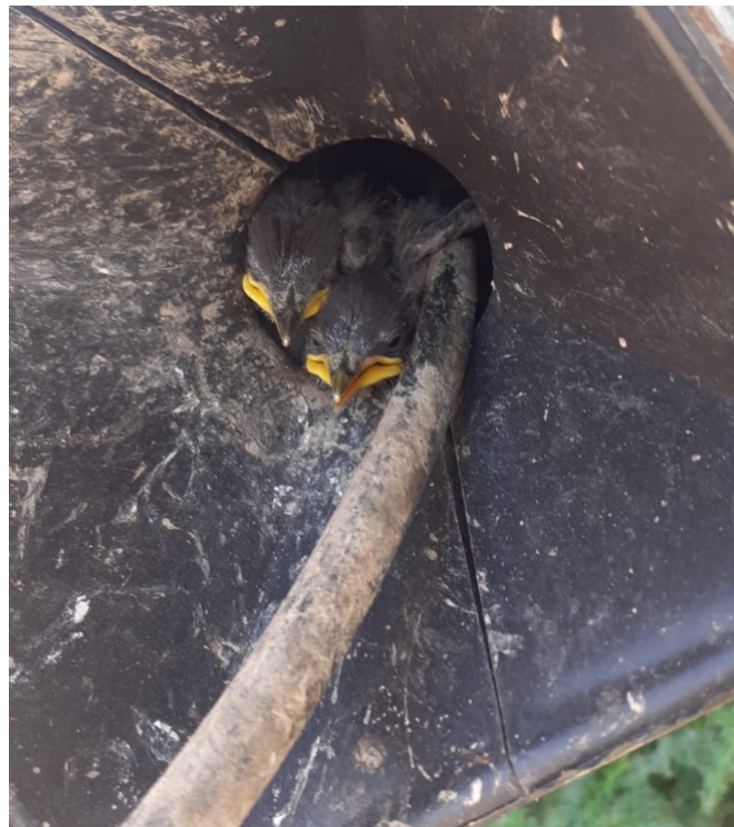
Fotografía 6: Nidificación por aves en el interior de uno de los seguidores.
