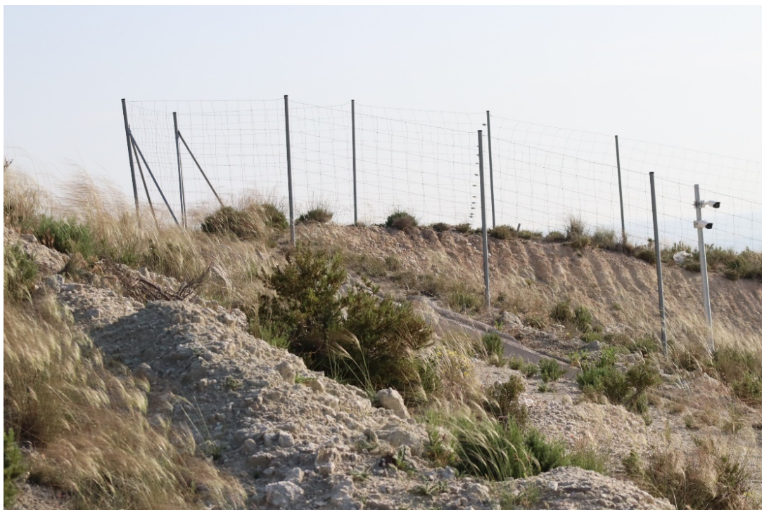
Fotografía 1: Crecimiento de la vegetación en los taludes y vallado perimetral
