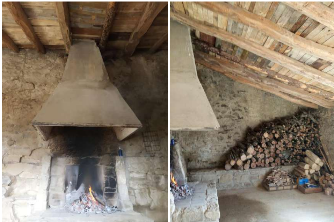
Fotos Reparaciones refugios
