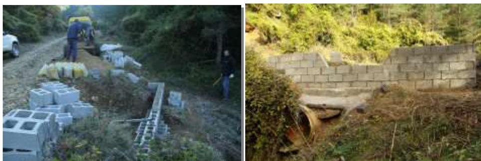
Fotos 10 y 11. Trabajos de construcción de badenes por las cuadrillas en el Paisaje Protegido.
