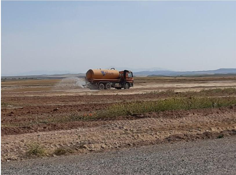
*Figura 1: Cuba regando zona de paso de maquinaria*
