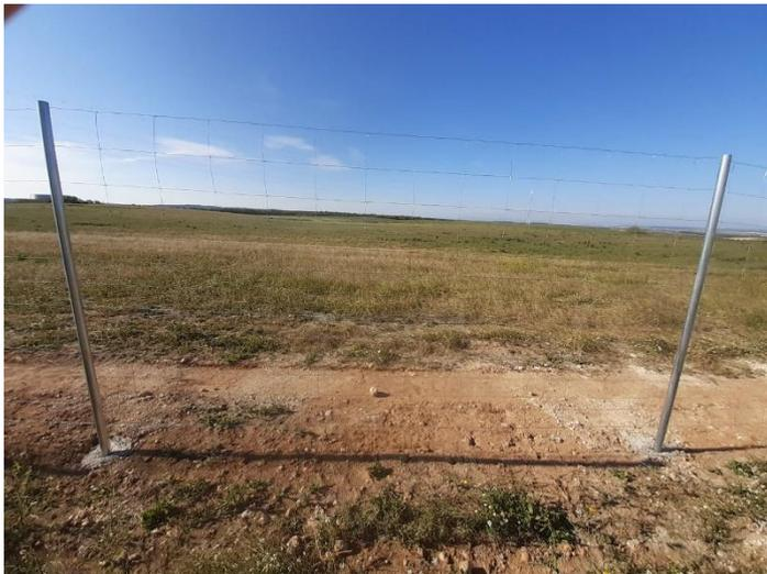
*Fig. 1 Detalle vallado perimetral instalado*
