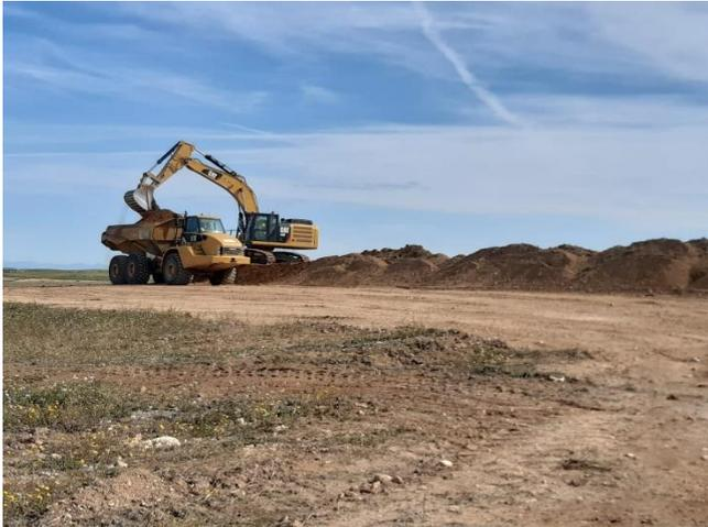
*Figura 1: Maquinaria de obra transportando tierra vegetal*
