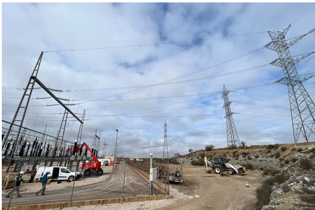
Figura 7 Tendido cable de alta tensión SET Ave
