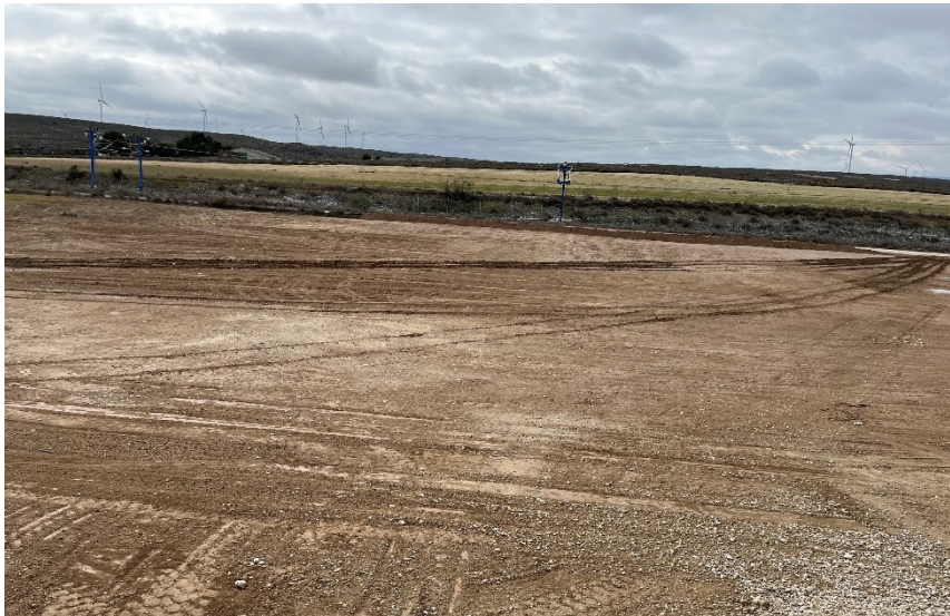
Figura 3 Retirada del acopio temporal de RNP de la CS Ave
