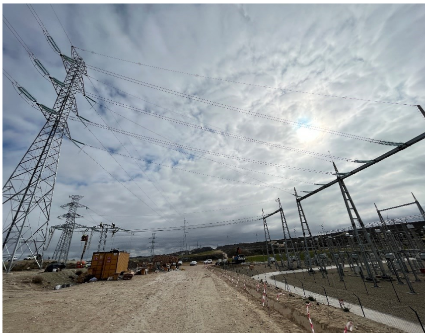
Figura 4 Tendido cable de alta tensión pórtico CS Ave
