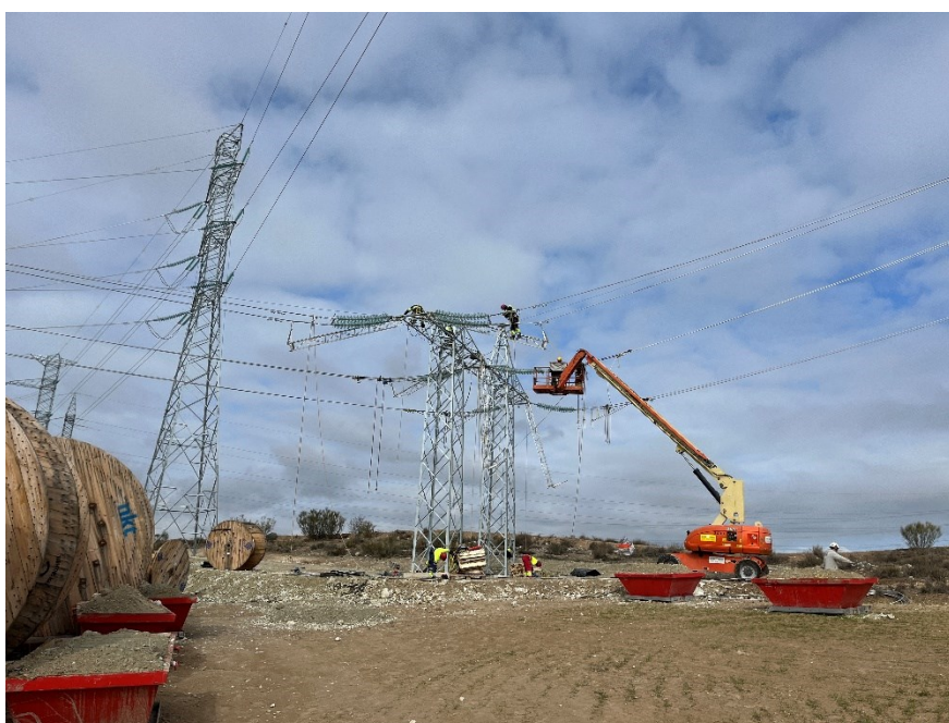
Figura 5 Tendido de cable de alta tensión Ap. 38
