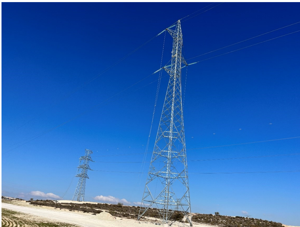
Figura 6 Tendido de cable de alta tensión Ap.99
