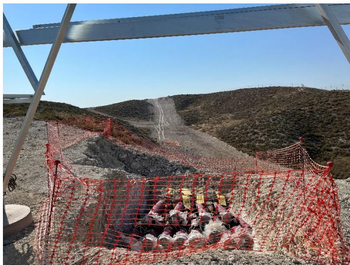
Figura 3 Hormigonado del apoyo soterrado
