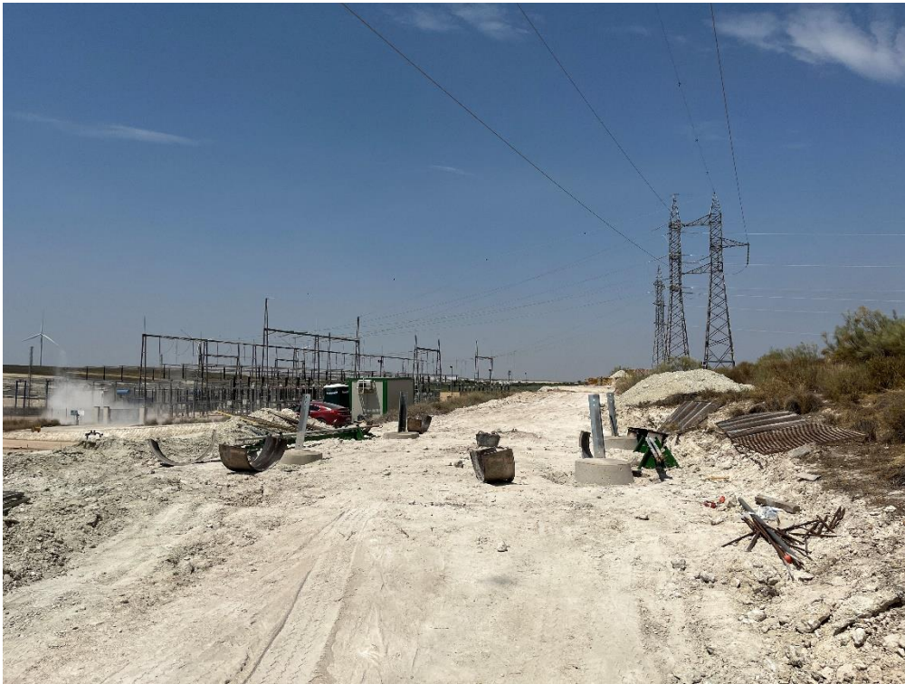
Figura 9 Apoyo 2 cimentado de la CS Ave- SET Ave
