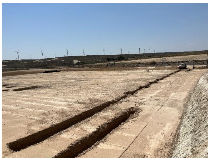
Figura 2 Excavación CS Ave
