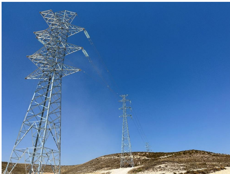
Figura 7 Cableado Ap. 1- Ap. 14
