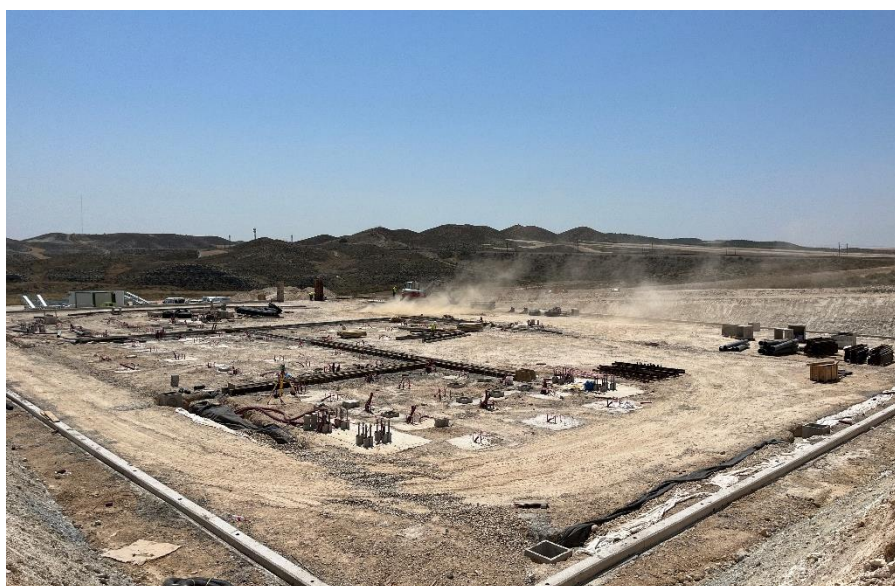
Figura 6 Orden y limpieza
