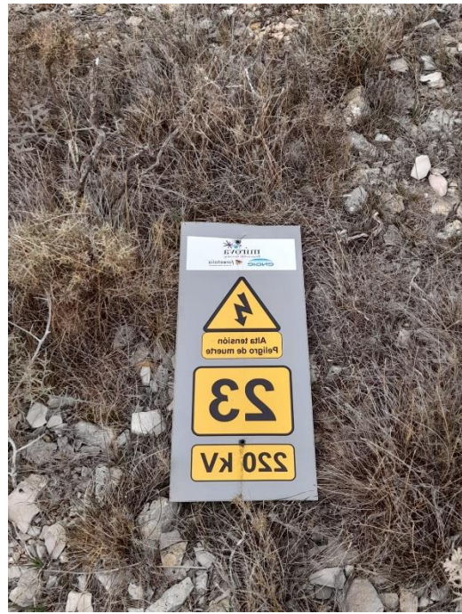
Fig 1 y 2. Baliza salvapájaros (izqda.) caída y cartel del vano (dcha.) 23 en el suelo.
