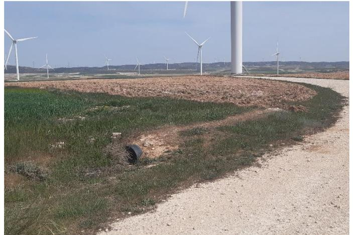
Fig. 4 Tubo de drenaje semitaponado con vegetación arbustiva en vial de acceso al aero LM5.05. Fuente: Elaboración propia
