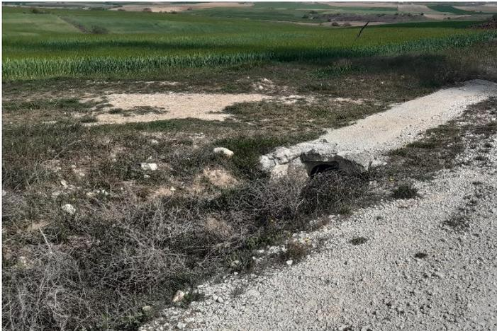
Fig. 3 Tubo de drenaje taponado por vegetación arbustiva en vial de acceso al aero LM5.11. Fuente: Elaboración propia
