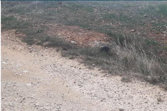
Fig. 1 Tubo de drenaje semitaponado con vegetación arbustiva en vial de acceso al aero LM5.03. Fuente: Elaboración propia
