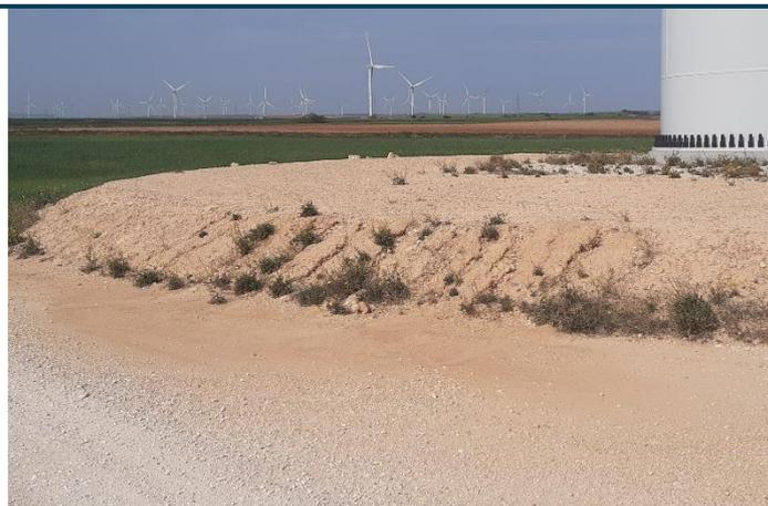
Fig. 2 Erosión hídrica en materiales lutíticos de la cimentación del aero LM5.10. Fuente: Elaboración propia
