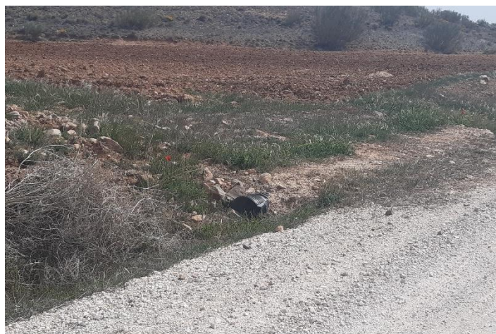
Fig.4 Tubo de drenaje semitaponado con sedimentos en vial de acceso al aero LM4.02. Fuente: Elaboración propia
