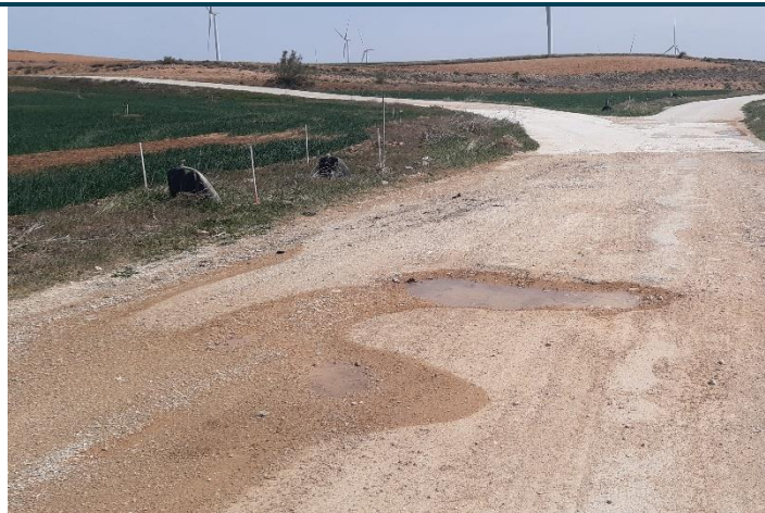
Fig. 2 Encharcamiento en vial de acceso al aero LM4.03. Fuente: Elaboración propia
