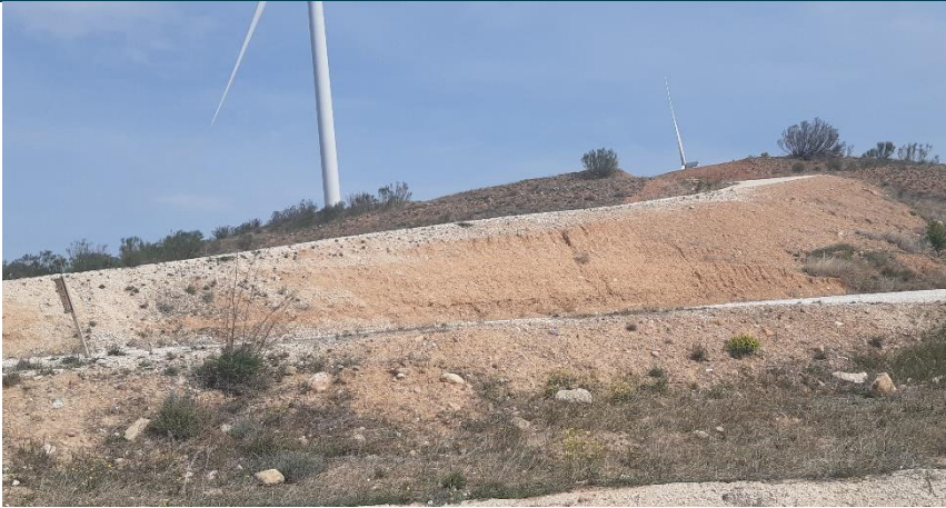
Fig. 1 Erosión hídrica en materiales lutíticos del talud de desmonte del vial de acceso al aero LM4.06. Fuente: Elaboración propia
