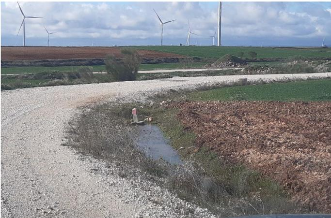
Fig. 3 Encharcamientos en margen del vial de acceso al aero LM2.10. Fuente: Elaboración propia
