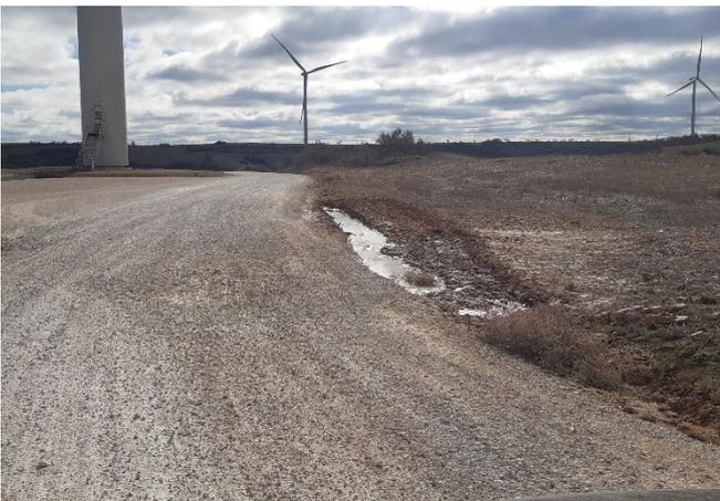
Fig. 3 Encharcamiento en margen dcho. de la plataforma del aero LM4.09. Fuente: Elaboración propia
