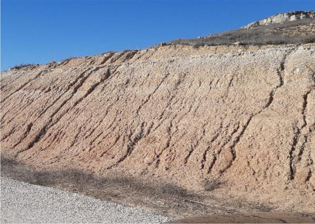
Fig. 1 Erosión hídrica en materiales lutíticos del talud de desmonte del vial de acceso al aero LM3.05. Fuente: Elaboración propia
