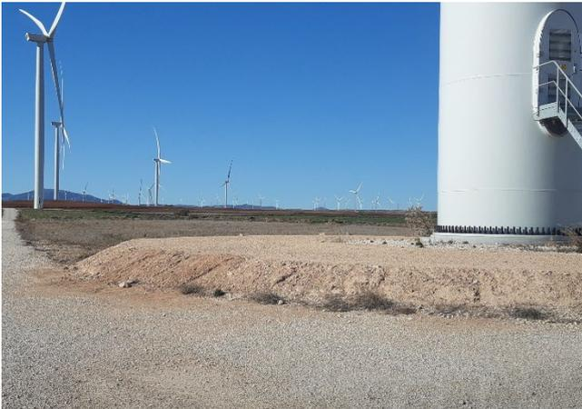
Fig. 3 Erosión hídrica en materiales lutítico-arenosos en la cimentación del aero LM5.10. Fuente: Elaboración propia
