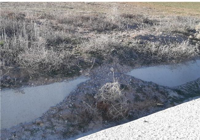
Fig. 5 Cuneta llena de sedimentos en vial de acceso a CÑC Y SLU. Fuente: Elaboración propia
