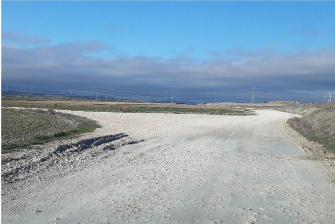
Fig. 1 Rodadas profundas en vial de acceso al aero LM2.06. Fuente: Elaboración propia
