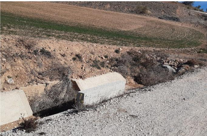
Fig. 3 Tubo de drenaje taponado por vegetación arbustiva y sedimentos en vial de acceso al aero LM4.02. Fuente: Elaboración propia
