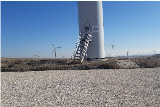
Fig. 3 Revegetación de la cimentación del aero LM3.03. Fuente: Elaboración propia
