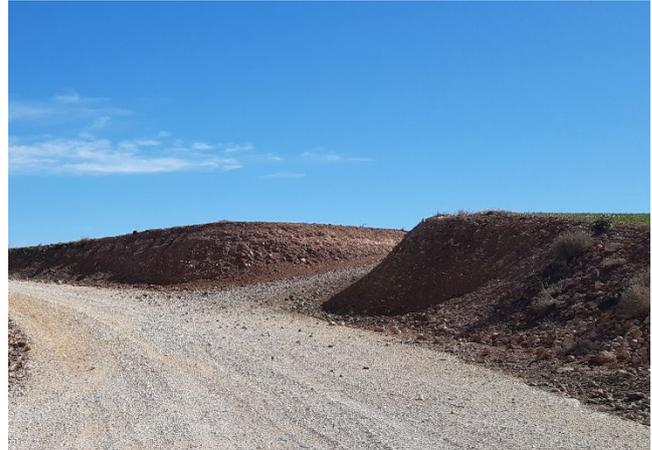
Fig. 4 Erosión hídrica en materiales lutíticos del talud de desmonte del vial de acceso al aero ES.04. Fuente: Elaboración propia
