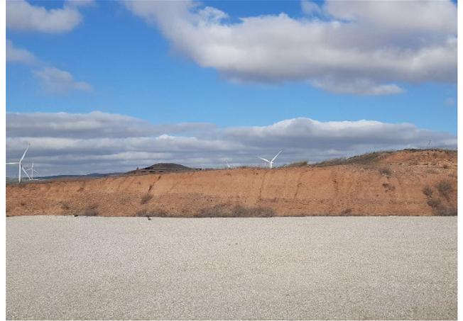
Fig. 2 Erosión hídrica leve en materiales lutíticos del talud de desmonte de la plataforma del aero LM4.02. Fuente: Elaboración propia
