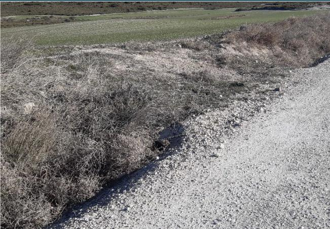
Fig. 1 Tubo de drenaje taponado con vegetación arbustiva en vial de acceso al aero LM2.06. Fuente: Elaboración propia
