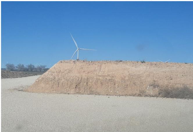
Fig. 5 Erosión hídrica en materiales lutíticos del talud de desmonte de la plataforma del aero LM4.06. Fuente: Elaboración propia
