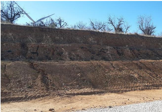
Fig. 5 Erosión hídrica en materiales lutíticos del talud de desmonte de la plataforma del aero CC.05. Fuente: Elaboración propia
