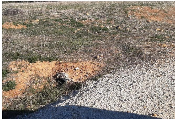
Fig. 6 Tubo de drenaje taponado por vegetación arbustiva y sedimentos en vial de acceso al aero SLU.06. Fuente: Elaboración propia
