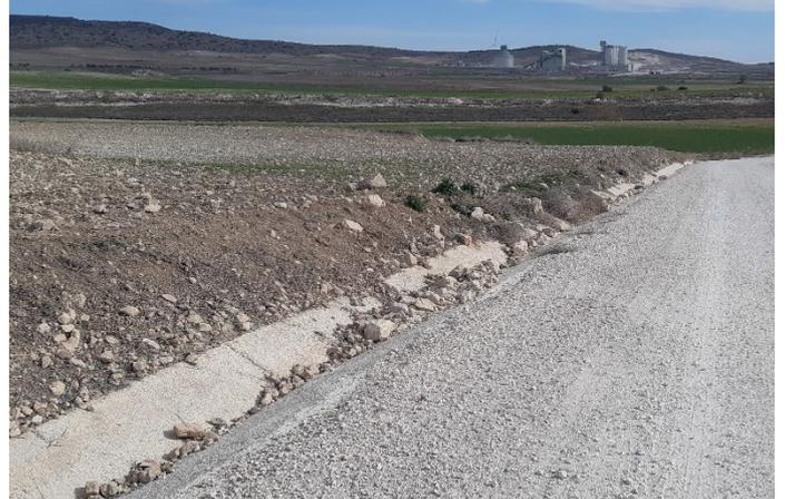
Fig. 2 Cuneta llena de sedimentos y rocas en el vial de acceso al aero LM3.08. Fuente: Elaboración propia
