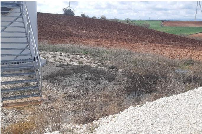
Fig. 5 Encharcamiento en la cimentación del aero LM5.03. Fuente: Elaboración propia
