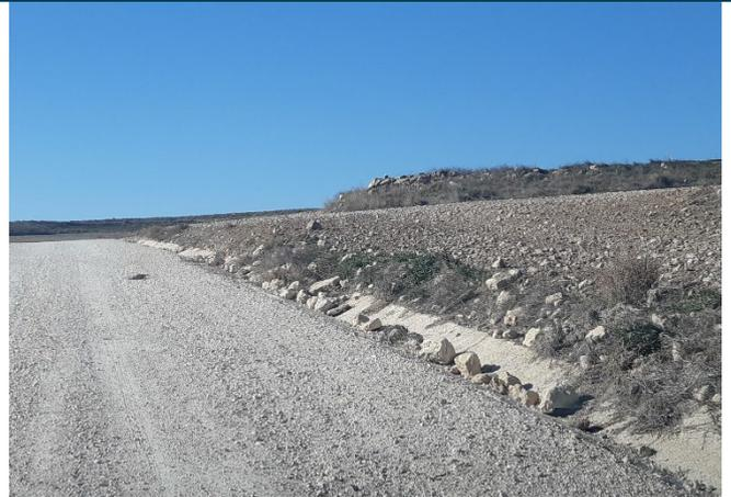
Fig. 2 Cuneta llena de sedimentos y rocas en el vial de acceso al aero LM3.08. Fuente: Elaboración propia
