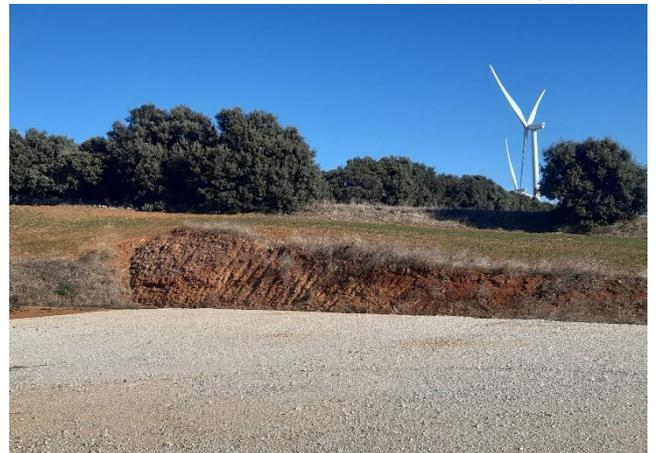
Fig. Erosión hídrica en materiales lutíticos del talud de desmonte de la plataforma del aero SLU.06. Fuente: Elaboración propia
