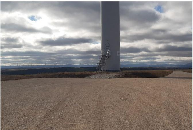
Fig. 5 Revegetación de la cimentación del aero ES.06 correcta. Fuente: Elaboración propia
