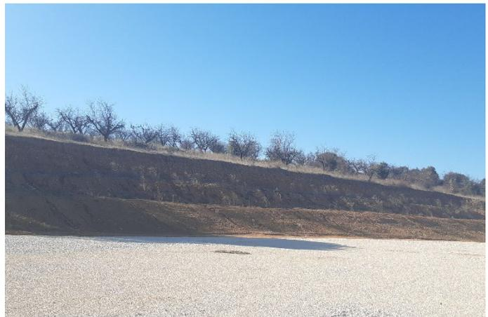
Fig. 6 Revegetación del talud de desmonte de la plataforma del aero CC.05 en proceso. Fuente: Elaboración propia
