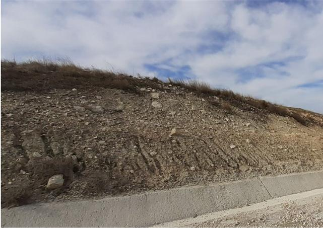
Fig. 1 Erosión hídrica en materiales lutíticos del talud de desmonte del vial de acceso al aero LM3.06. Fuente: Elaboración propia
