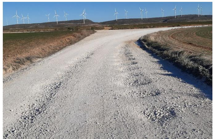
Fig. 4 Vial de acceso a CNC Y SLU muy bacheado (extensible a todo el vial). Fuente: Elaboración propia
