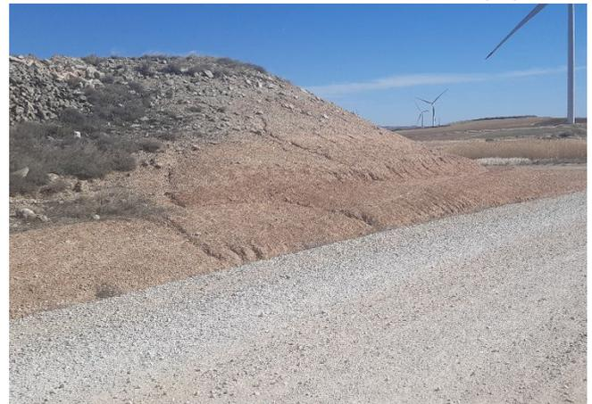
Fig. Erosión hídrica en materiales lutíticos del talud de desmonte del vial de acceso al aero LM3.08. Fuente: Elaboración propia
