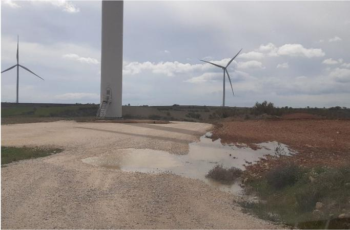
Fig. 1 Encharcamientos en plataforma del aero LM4.09. Fuente: Elaboración propia
