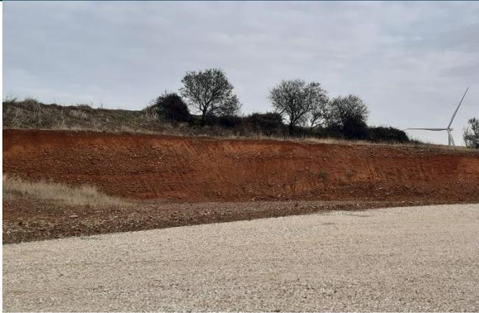
Fig. 1 Erosión hídrica en materiales lutíticos del talud de desmonte de plataforma del aero CC2. Fuente: Elaboración propia
