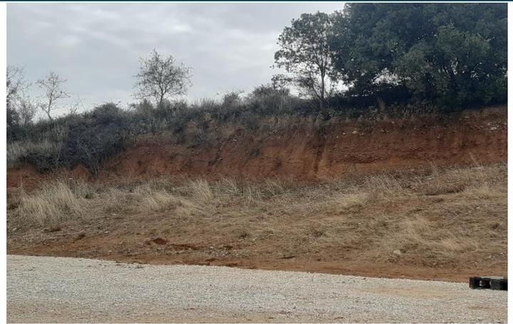
Fig. 2 Erosión hídrica en materiales lutíticos del talud de desmonte de plataforma del aero CC5. Fuente: Elaboración propia
