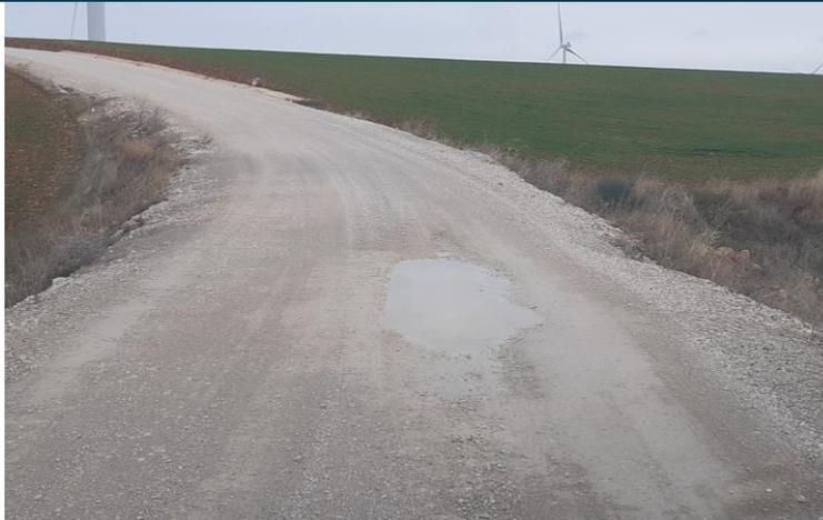
Fig. 1 Encharcamiento en vial de acceso al aerogenerador CNC.01. Fuente: Elaboración propia
