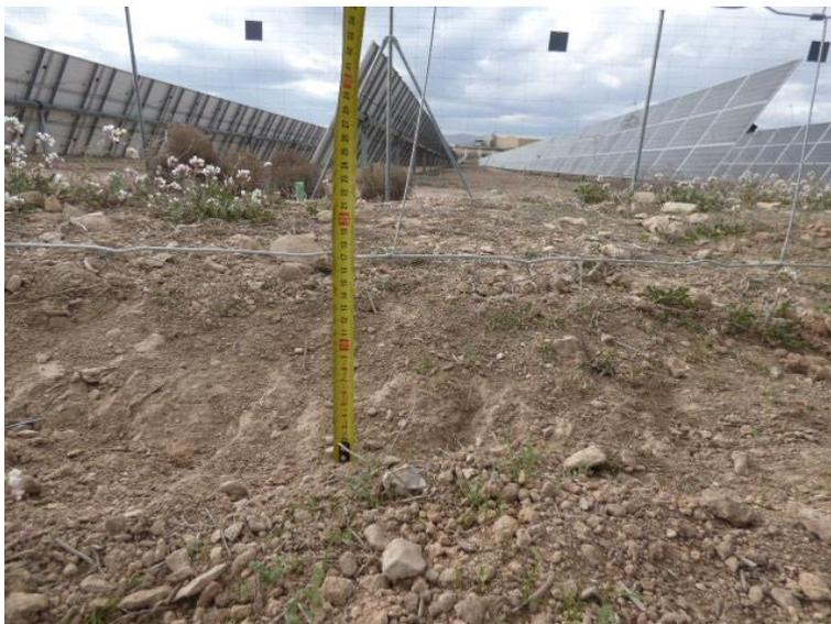
Figura 31. Altura libre del vallado (18 cm) inferior a la indicada en la DIA (20 cm), por lo que será objeto de subsanación
