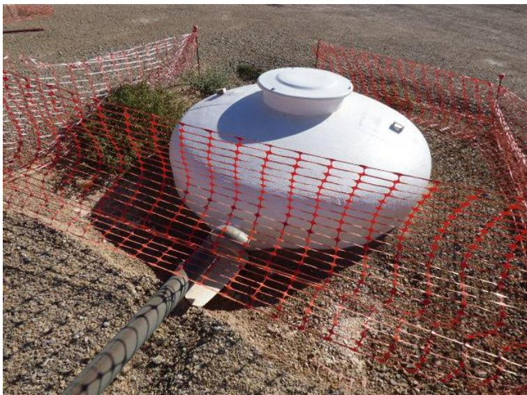
Figura 9. Las aguas residuales generadas en los baños disponibles en las casetas de obra son almacenadas temporalmente en un depósito estanco
