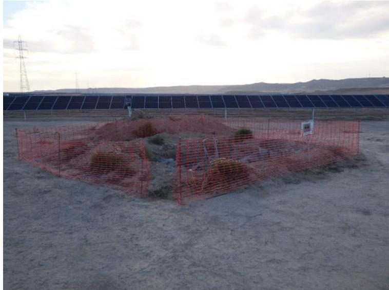
Figura 45. Punto acondicionado para el vertido del hormigón sobrante y la limpieza de las canaletas de las hormigoneras
