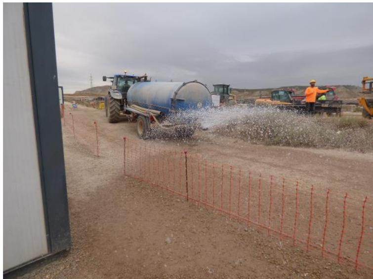
Figura 2. Cuba aplicando riego en uno de los caminos interiores de la obra
