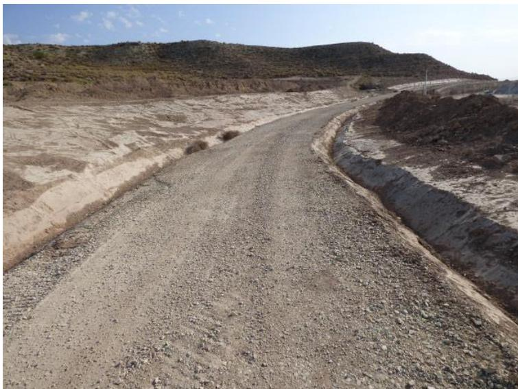
Figura 6. Camino perimetral con cunetas que canalizarán el agua de escorrentía evitando encharcamientos
