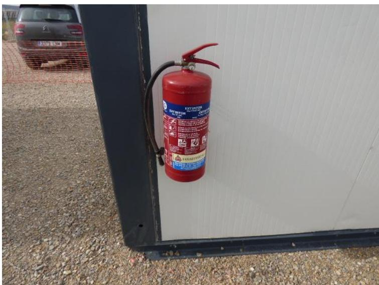
Figura 15. Extintor en una de las casetas de obra
