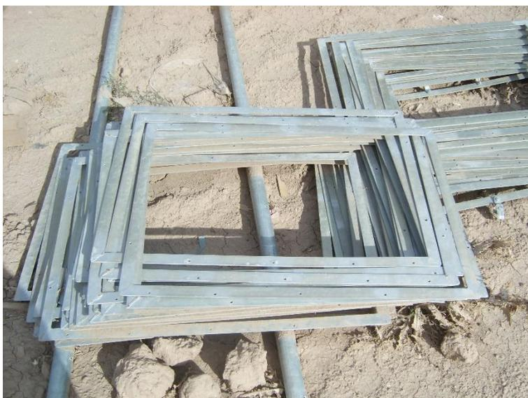
Figura 32. Pasos de fauna acopiados en la obra que serán instalados antes de la finalización de la fase de construcción
