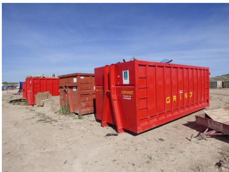
Figura 41. Contenedores identificados mediante cartelería para el depósito de residuos de obra no peligrosos (madera, plástico, metal, etc.)
