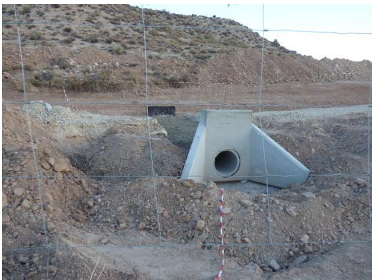
Figura 7. Obra de drenaje transversal del camino perimetral
