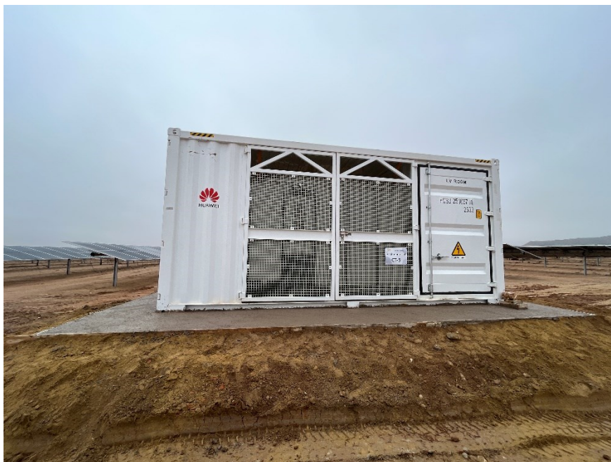
Figura 5 Cimentación de la base del CT-3
