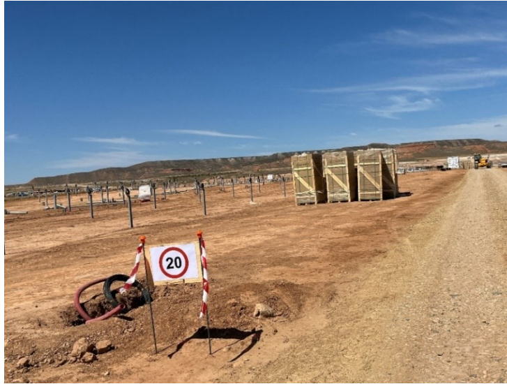
Figura 2 Señalización en obra
