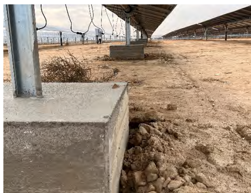
Figura 23 Cimentación de las hincas rechazadas
