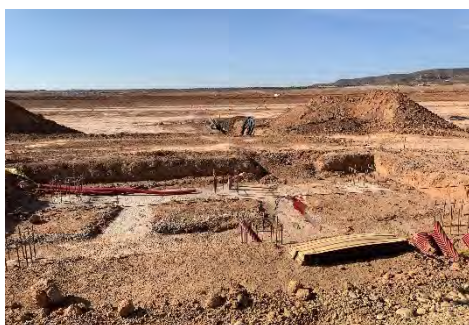
Figura 4 Trabajos de cimentación
