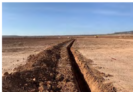
Figura 3 Apertura de zanjas
