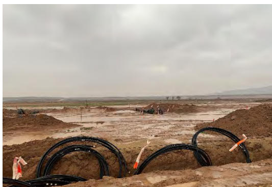
Figura 9 Tendido de cable de baja tensión
