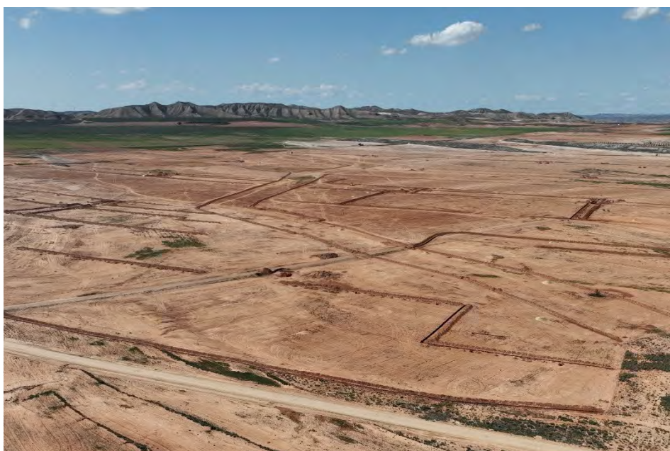
Figura 38 Apertura de zanjas
