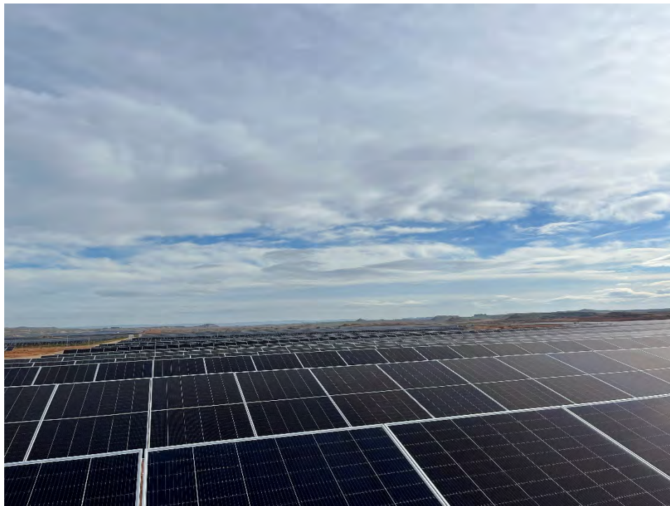
Figura 41 Montaje de los módulos
