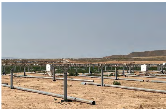
Figura 11 Montaje de los inversores
