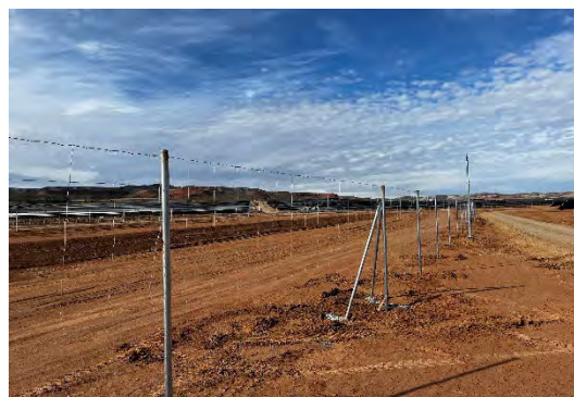
Figura 36 Instalación del vallado perimetral
