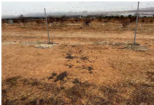
Figura 35 Instalación del vallado perimetral
