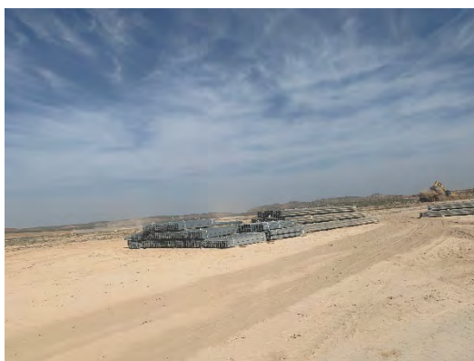
Figura 26 Acopio del material de construcción
