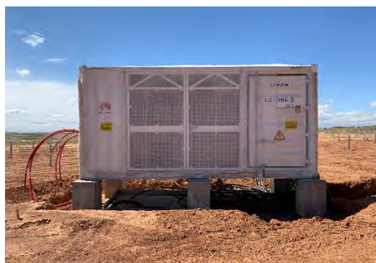
Figura 12 Cableado de los centros de transformación
