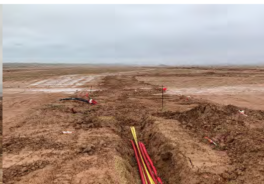
Figura 10 Tendido de cable de media tensión
