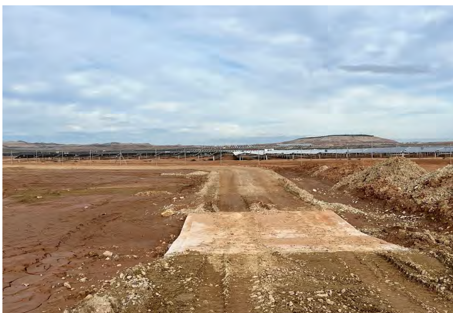
Figura 40 Cimentación del vial interno
