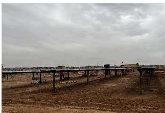
Figura 8 Montaje de los módulos fotovoltaicos
