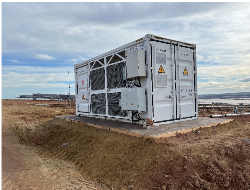
Figura 2 Cimentación de la base del CT
