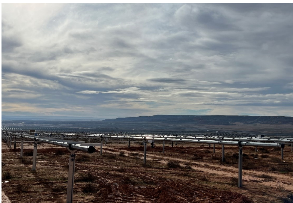
Figura 7 Montaje de los trackers
