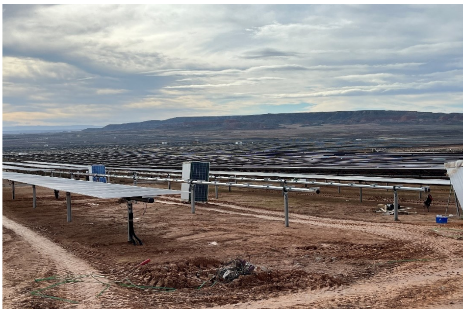
Figura 6 Montaje de los módulos
