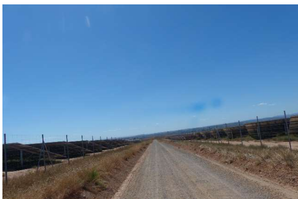
Foto 3. Vista del camino y cunetas entre las dos plantas
