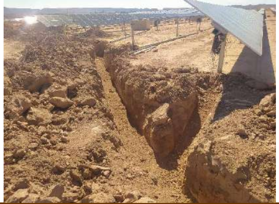
Fot 1 y 2. Zanja de BT entre los sectores A4 y A6 de la PSFV Pitarco A
