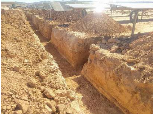
Fot 3 y 4. Zanja de BT entre los sectores A5 y A7 de la PSFV Pitarco A
