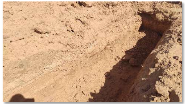
Fot 1 y 2. Zanjas para la conexión y cimentación del CT 7 en el sector 3 de Pitarco B
