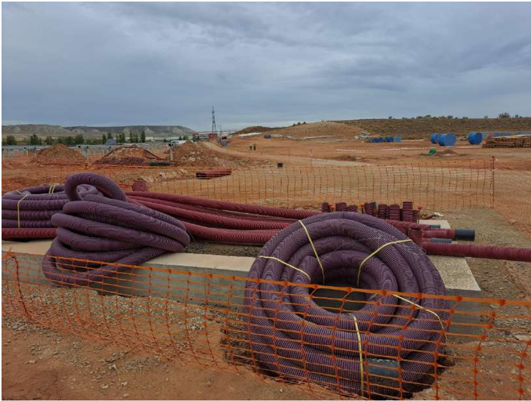
Foto 10. Cimentaciones para centros de transformación (CT)
