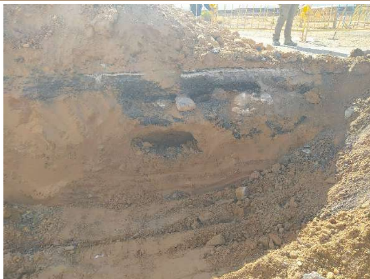
Fot 3. Perfil del vial de acceso al polígono "El Pitarco".
