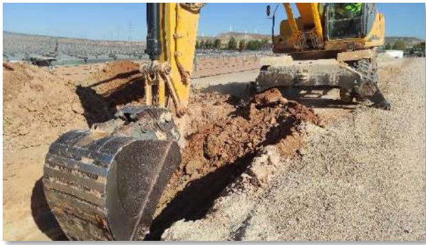
Fot 1 y 2. Zanja de MT de Vial 2 a Subestación PSFV Pitarco A
