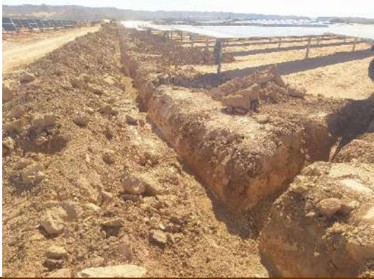
Fot 1 y 2. Zanja de BT entre los sectores A4 y A6 de la PSFV Pitarco A
