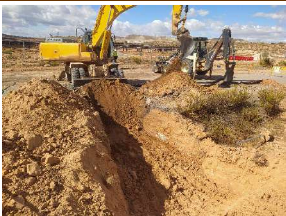
Fot 1 y 2. Ejecución de la zanja de evacuación de Pitarco B4 a B1 y B2, atravesando el vial de acceso al polígono "El Pitarco".
