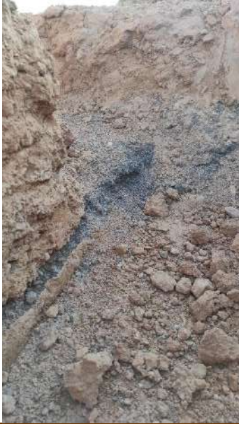
Fot 1 y 2. Detalle de los restos de alquitran de asfalto por debajo de los aportes realizados en los sectores B1 y B2 en PSFV Pitarco B
