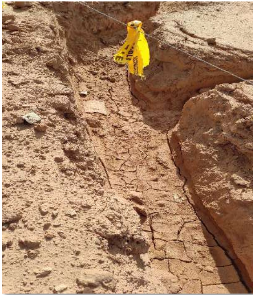
Fot 1 y 2. Zanja de BT entre los sectores A5 y A7 de la PSFV Pitarco A
