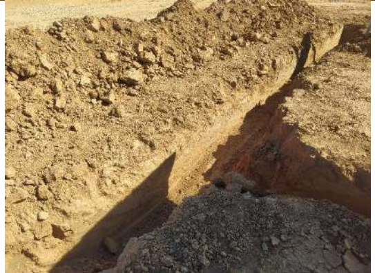
Fot 3 y 4. Zanja de BT entre los sectores A5 y A7 de la PSFV Pitarco A
