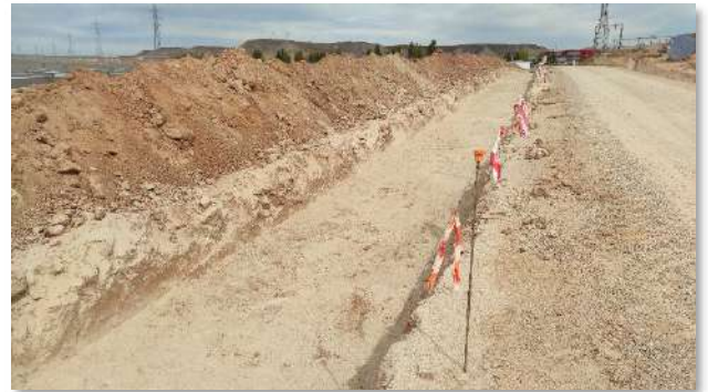
Fot 3 y 4. Arenado de la zanja de MT de Vial 2.
