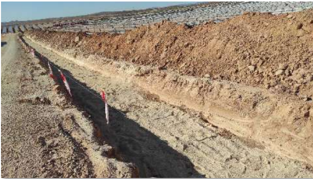
Fot 3 y 4. Arenado de la zanja de MT de Vial 2.
