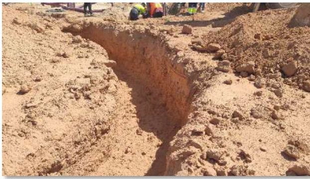
Fot 1 y 2. Zanjas para la conexión y cimentación del CT 7 en el sector 3 de Pitarco B
