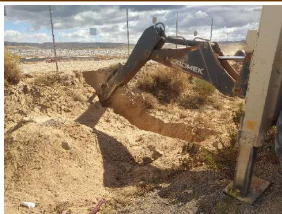
Fot 1 y 2. Ejecución de la zanja de evacuación de Pitarco B4 a B1 y B2, atravesando el vial de acceso al polígono "El Pitarco".
