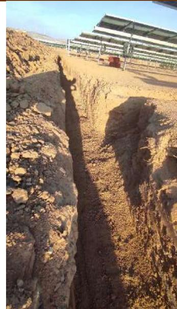
**Fot 3 y 4. Zanja de BT y MT en los sectores 1 y 2 de Pitarco B**
