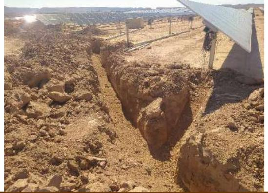
Fot 1 y 2. Zanja de BT entre los sectores A4 y A6 de la PSFV Pitarco A
