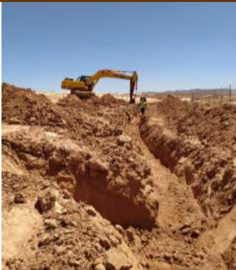
Fot. 11 y 12 Realización del zanjado de BT en Zonas 1, 2 y 3 de PSFV Pitarco A Norte
