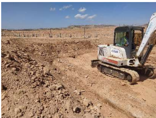
Fot. 1 y 2. Realización del zanjeado de Subestación junto a Campa en PSFV Pitarco A
