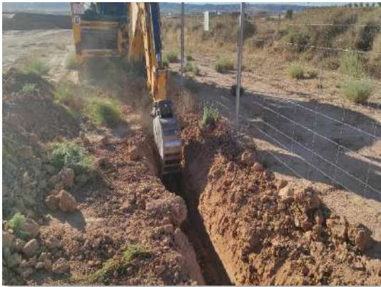
Fot 5 y 6. Zanjeado de CCTV en Pitarco A Oeste
