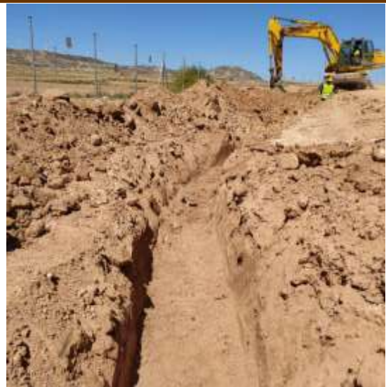
Fot. 11 y 12 Realización del zanjado de BT en Zonas 1, 2 y 3 de PSFV Pitarco A Norte
