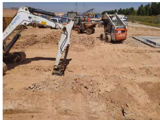
Fot. 1 y 2. Realización del zanjeado de Subestación junto a Campa en PSFV Pitarco A
