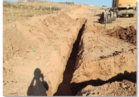
Fot 1 y 2. Zanja de BT en Pitarco C
