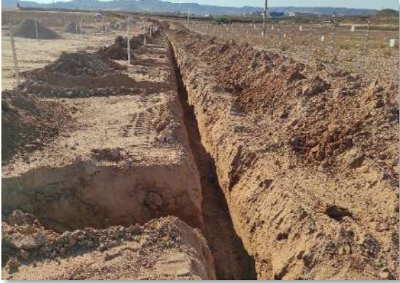
Fot 1 y 2. Zanja de BT en Pitarco C
