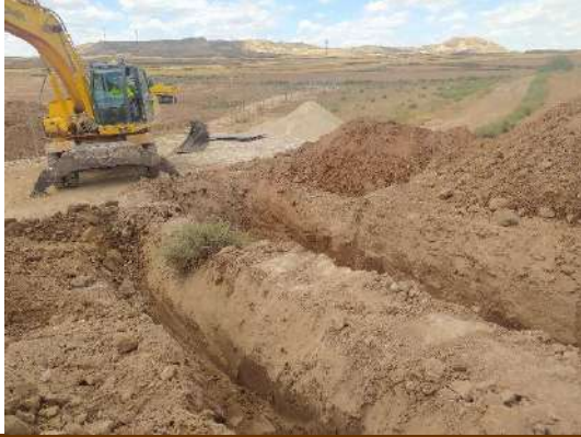
Fot 3 y 4. Zanjado entre accesos PSFV Pitarco A y Pitarco A Oeste
