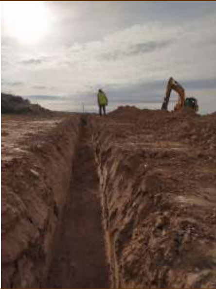
Fot. 9 y 10 Realización del zanjado de BT en Zonas 1, 2 y 3 de PSFV Pitarco A Norte
