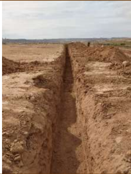
Fot. 9 y 10 Realización del zanjado de BT en Zonas 1, 2 y 3 de PSFV Pitarco A Norte
