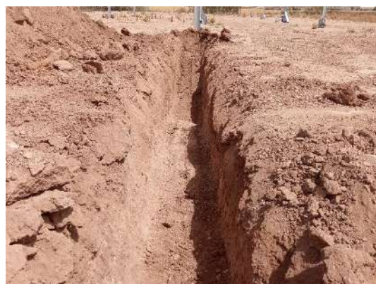
Fot. 1, 2, 3 y 4. Realización del zanjeado de BT en A1, A2 y A3 de PSFV Pitarco A Norte
