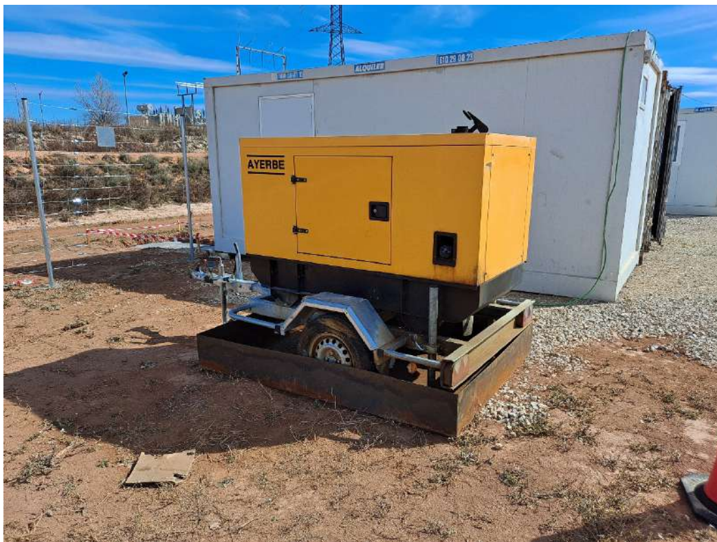
Detalle cubeto de retención
