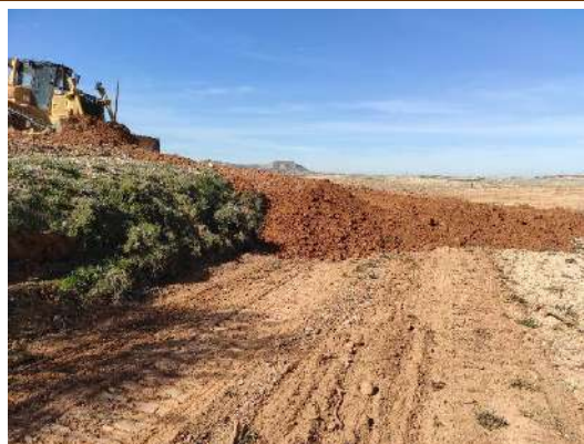
Fot. 4. Desmonte de tierras con bulldozer en el Sector 7 de Pitarco A
