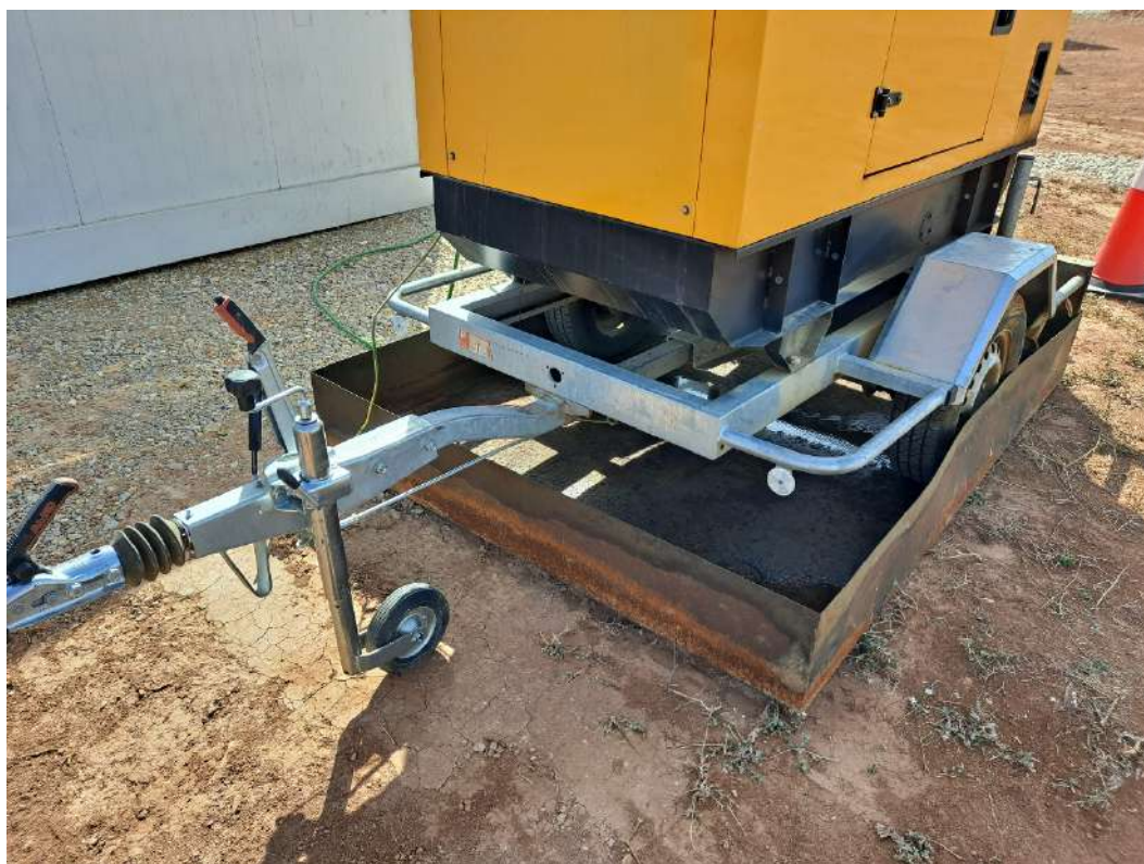
Detalle cubeto de retención
