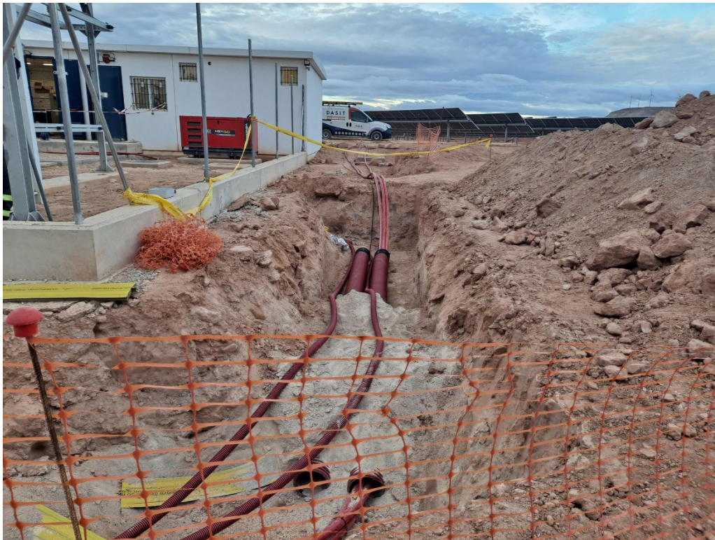
Foto 4. Zanjas para entubado línea de evacuación SET
