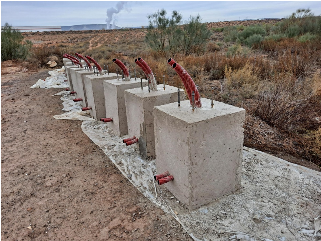
Foto 8. Encofrado defectuoso
