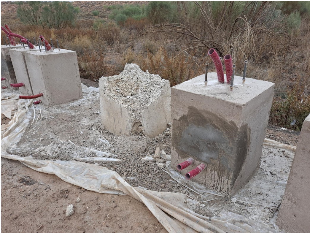
Foto 8. Encofrado defectuoso
