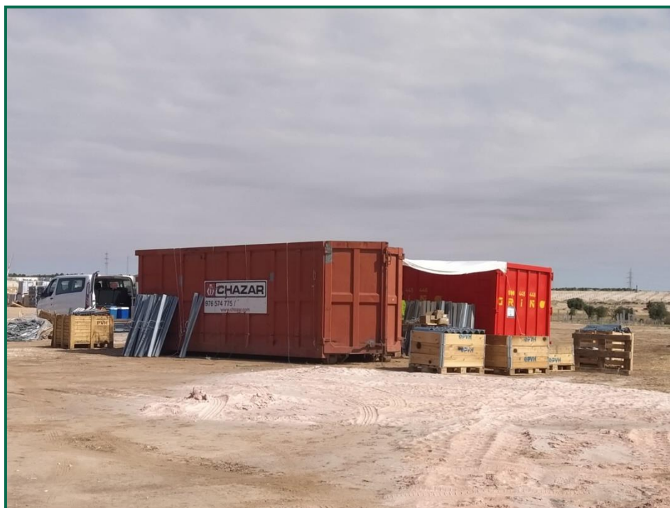
Fotografía 9. Contenedores residuos inertes
