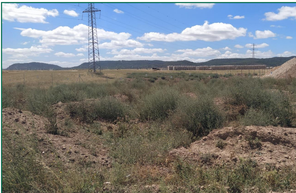
Fotografía 4. Caballones de tierra vegetal.
