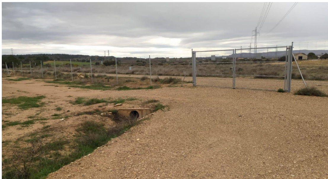
Foto 1. Vista del acceso al recinto sur de la planta fotovoltaica
