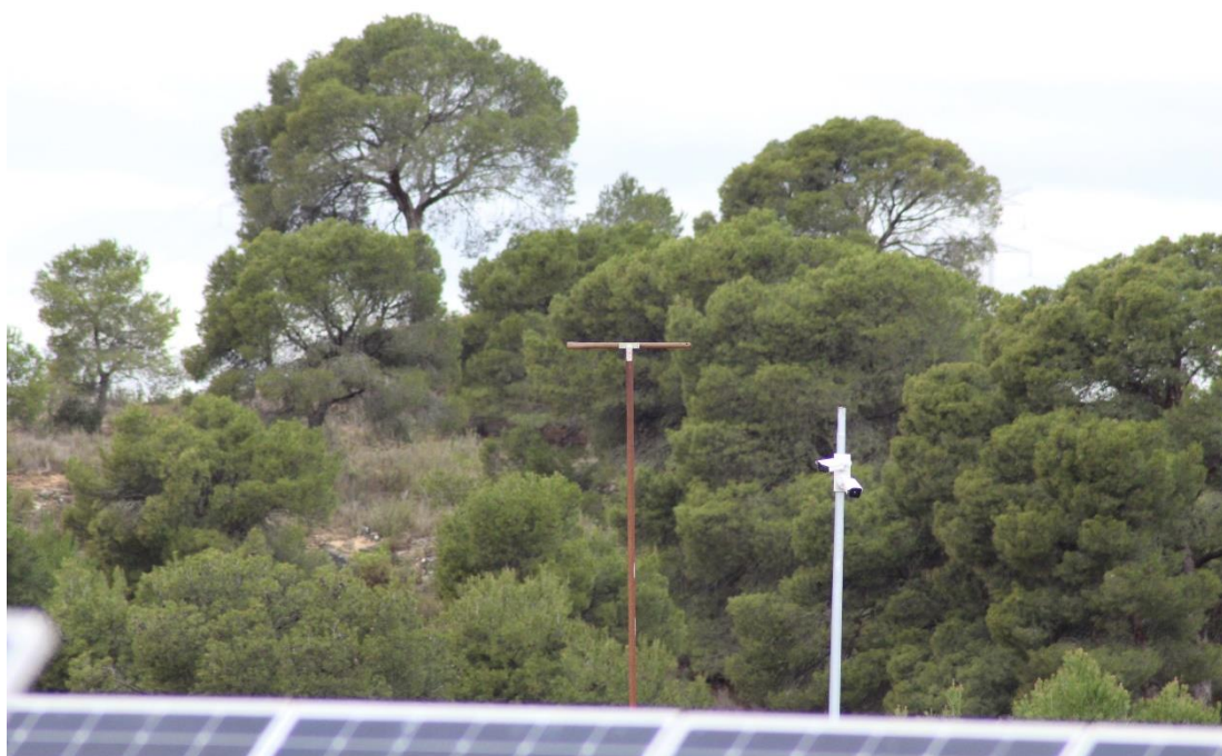
Foto 10. Vista de los posaderos instalados
