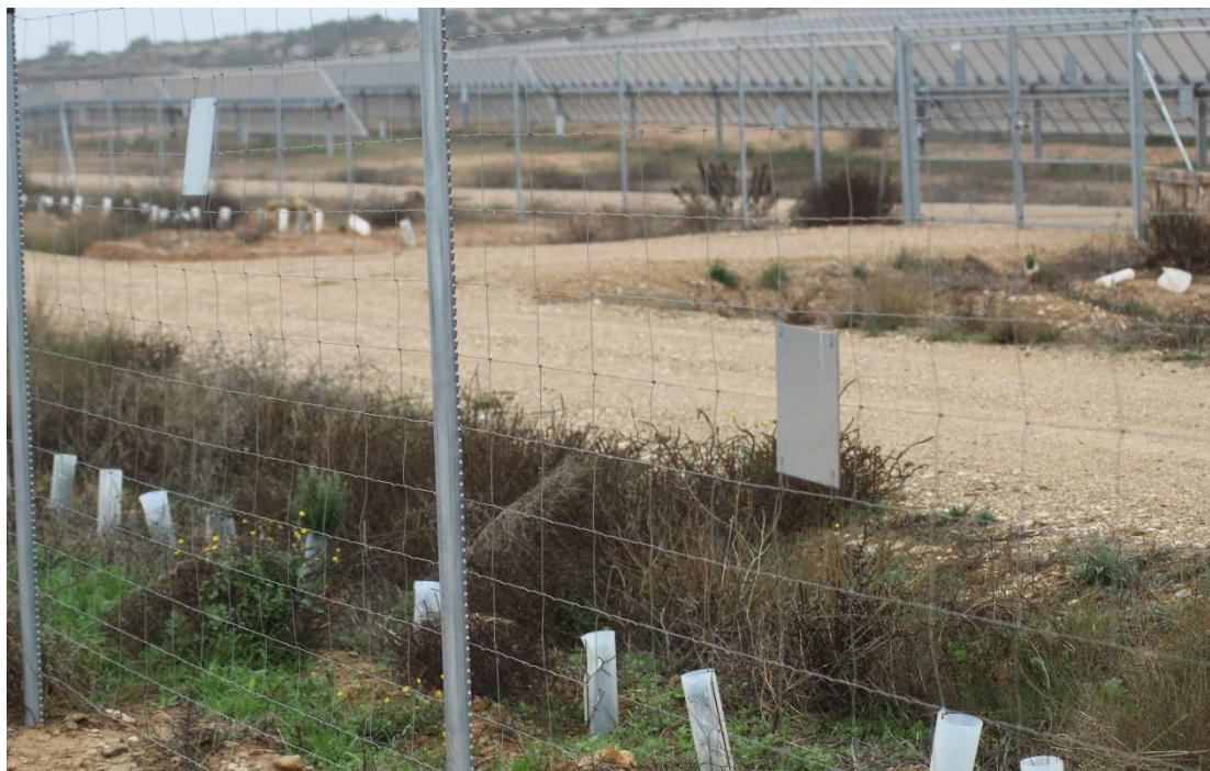
Foto 3. Vista del recinto noreste de la planta fotovoltaica desde el interior del recinto noroeste. Se aprecia el camino de acceso y las plantaciones realizadas ambos lados de éste
