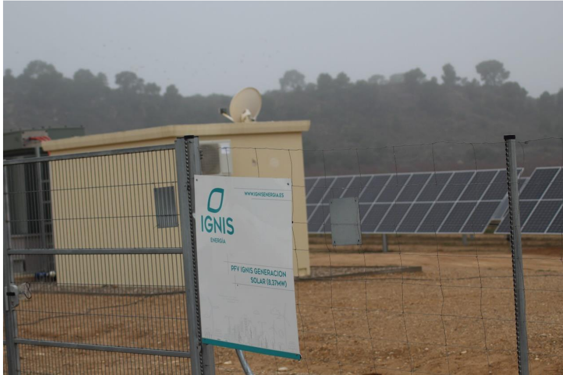
Foto 1. Acceso a la planta fotovoltaica (zona norte)
