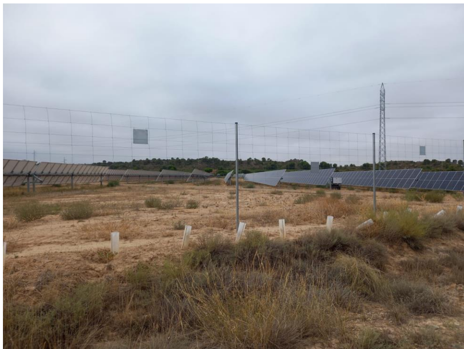
Foto 3. Vista general de la planta fotovoltaica desde el camino de acceso
