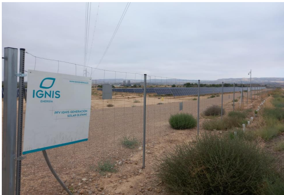
Foto 1. Acceso a la planta fotovoltaica (zona norte)
