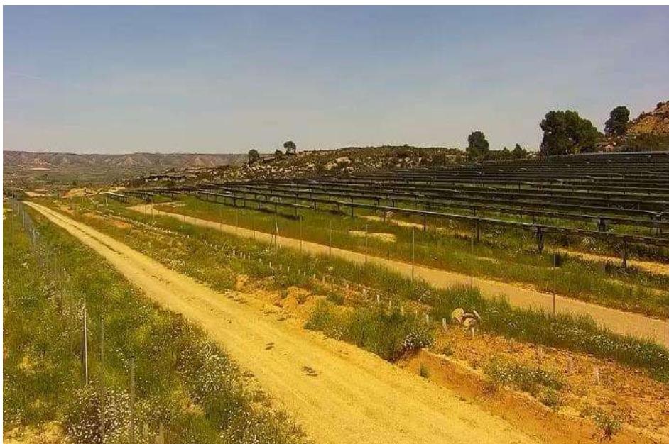
Foto 3. Vista general del estado de la vegetación de la planta fotovoltaica.
