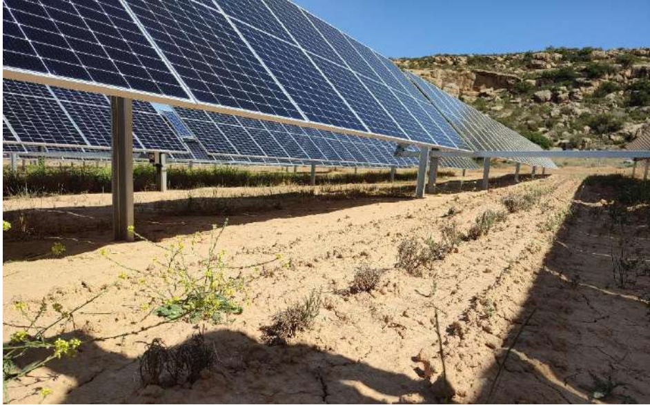
Foto 1. Estado de las plantaciones entre seguidores antes de los riegos del mes de junio
