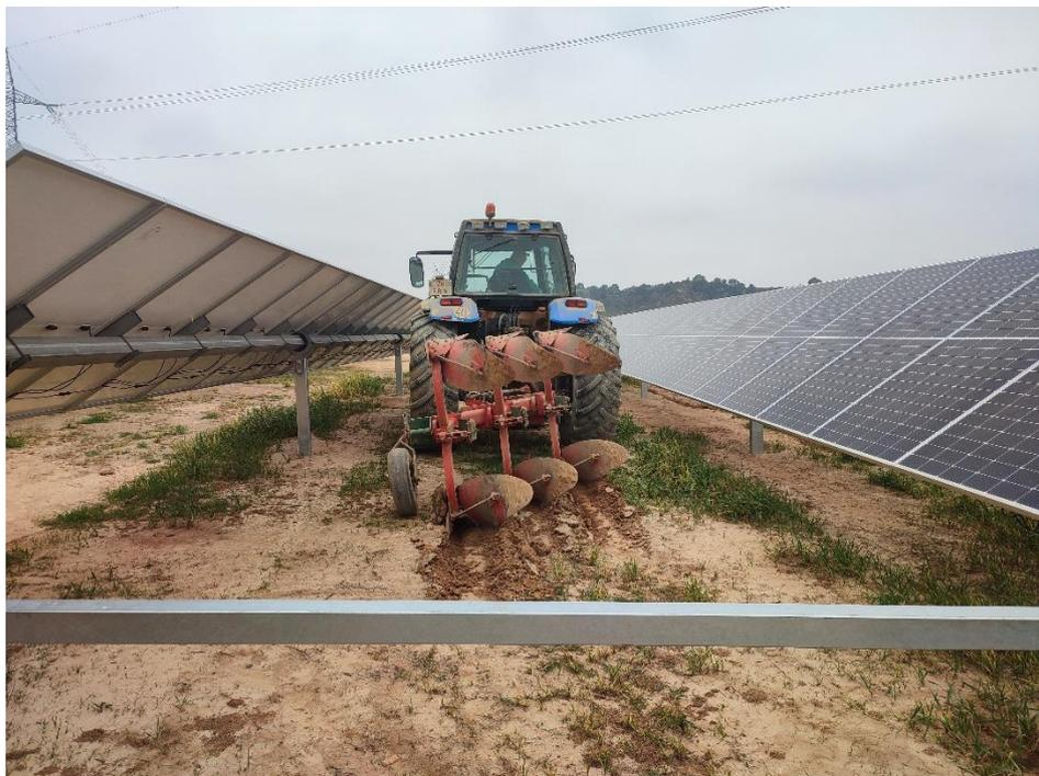
*Foto 1. Descompactación del terreno en campo de seguidores*
