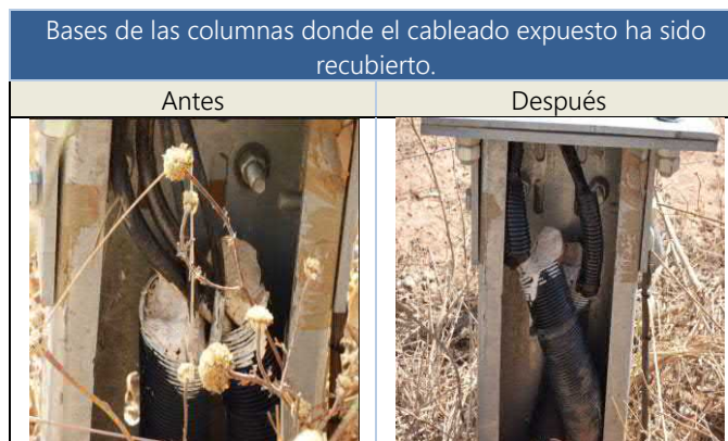
Imágenes 8 y 9: bases de las columnas antes y después de la protección del cableado
