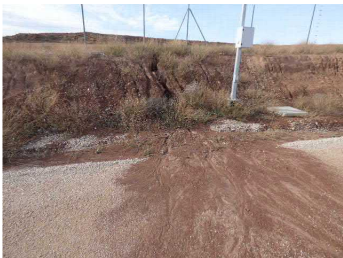
Imágenes 1 y 2: Signo de erosión en el talud de la zona sur del parque, y material depositado en el vial inferior (imagen izquierda). Después de la re compactación (imagen derecha).
