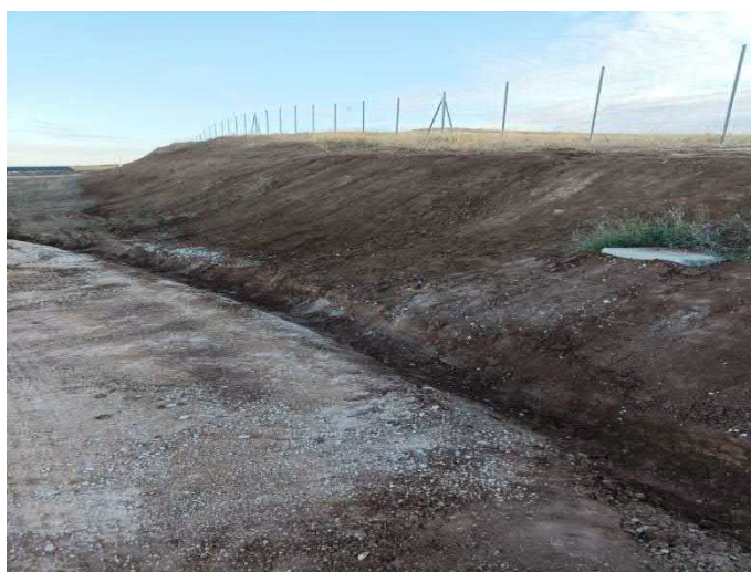
Imágenes 1 y 2: Signo de erosión en el talud de la zona sur del parque, y material depositado en el vial inferior (imagen izquierda). Después de la re compactación (imagen derecha).
