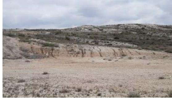
Fig. 6 Erosión hídrica en materiales lutíticos y margosos del talud de desmonte de plataforma del aero VGI.02. Fuente: Elaboración propia
