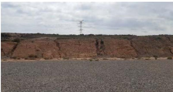
Fig. 3 Erosión hídrica extrema en materiales lutíticos del talud de desmonte de plataforma del aero VGI.10. Fuente: Elaboración propia
