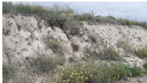
Fig. 4 Erosión hídrica en materiales margo-arenosos del talud de desmonte del vial de acceso al aero VGI.10. Fuente: Elaboración propia
