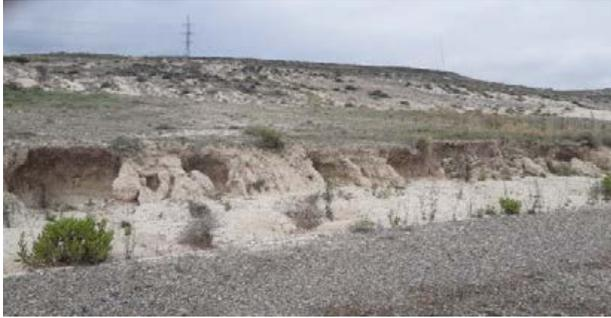
Fig. 5 Erosión hídrica en materiales margosos del talud de desmonte de plataforma del aero VGI.07. Fuente: Elaboración propia
