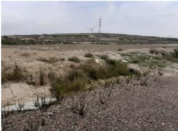
Fig. 5 Cuneta llena de sedimentos en vial de acceso al aero VGI.08. ODT afectada por vegetación arbustiva y sedimentos. Elaboración propia
