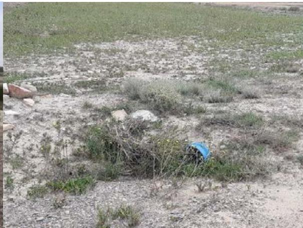
Fig. 6 Tubo de drenaje semitaponado con vegetación arbustiva y sedimentos en vial de acceso al aero VGI.07. Fuente: Elaboración propia
