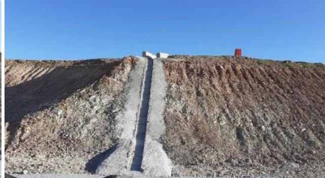
Extendido de la tierra vegetal en todos los taludes de viales y campos de montaje de los aerogeneradores.
