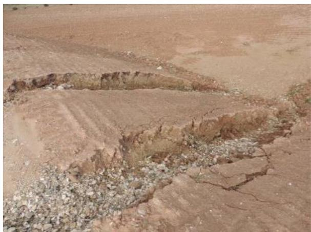
Una forma de evitar esta erosión es conducir las aguas justo a la zona de vértice y realizar una canaleta de hormigón en ese punto. En este punto esta canaleta tendría una mayor efectividad.
