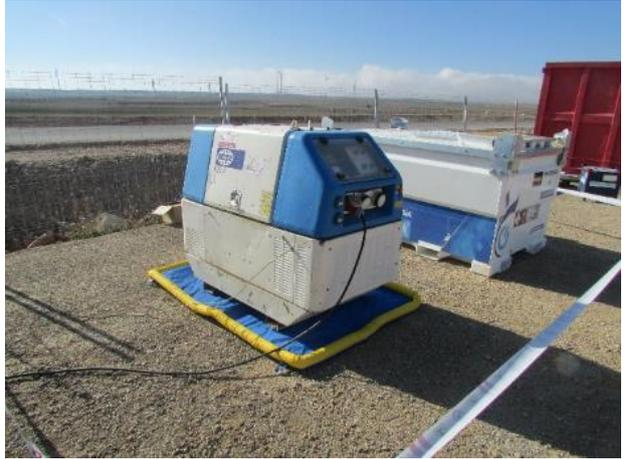
Grupo electrógeno con bandeja antiderrame interior integrada y lona antivertidos.
