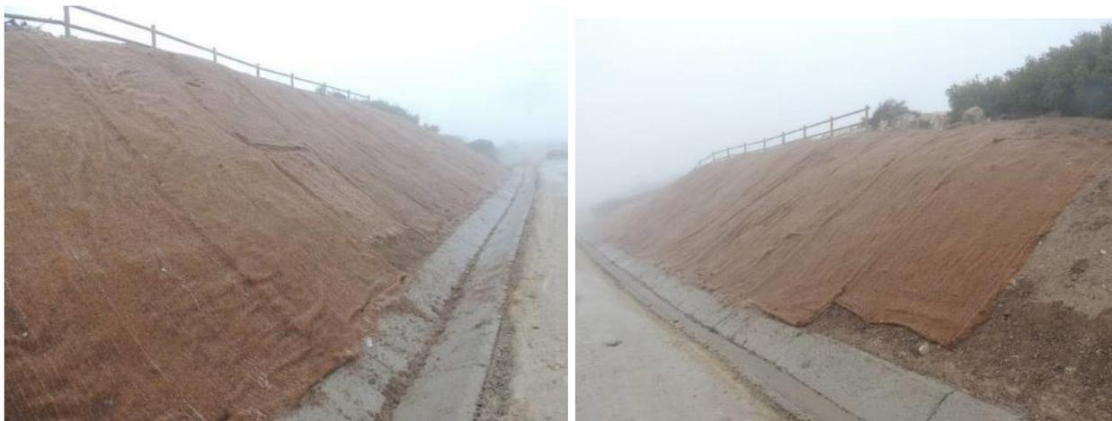
Acabado de la restauración de la ladera, tras la colocación de las geoceldas, tierra vegetal, siembra a voleo y colocación de las mantas de coco como sujeción.
