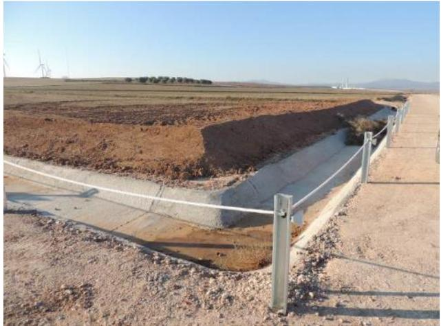
Colocación de bionda grises y marrones, junto con la colocación de postes con cuerda termolacados en marrón en el ramal 1.
