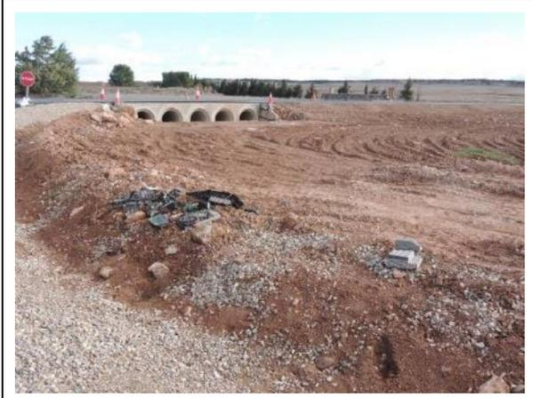
Tras las continuas lluvias es necesario terminar las obras de cunetas, mejorar los accesos del agua a los emboquilles de las tuberías en ambos lados y retirar los escombros.
