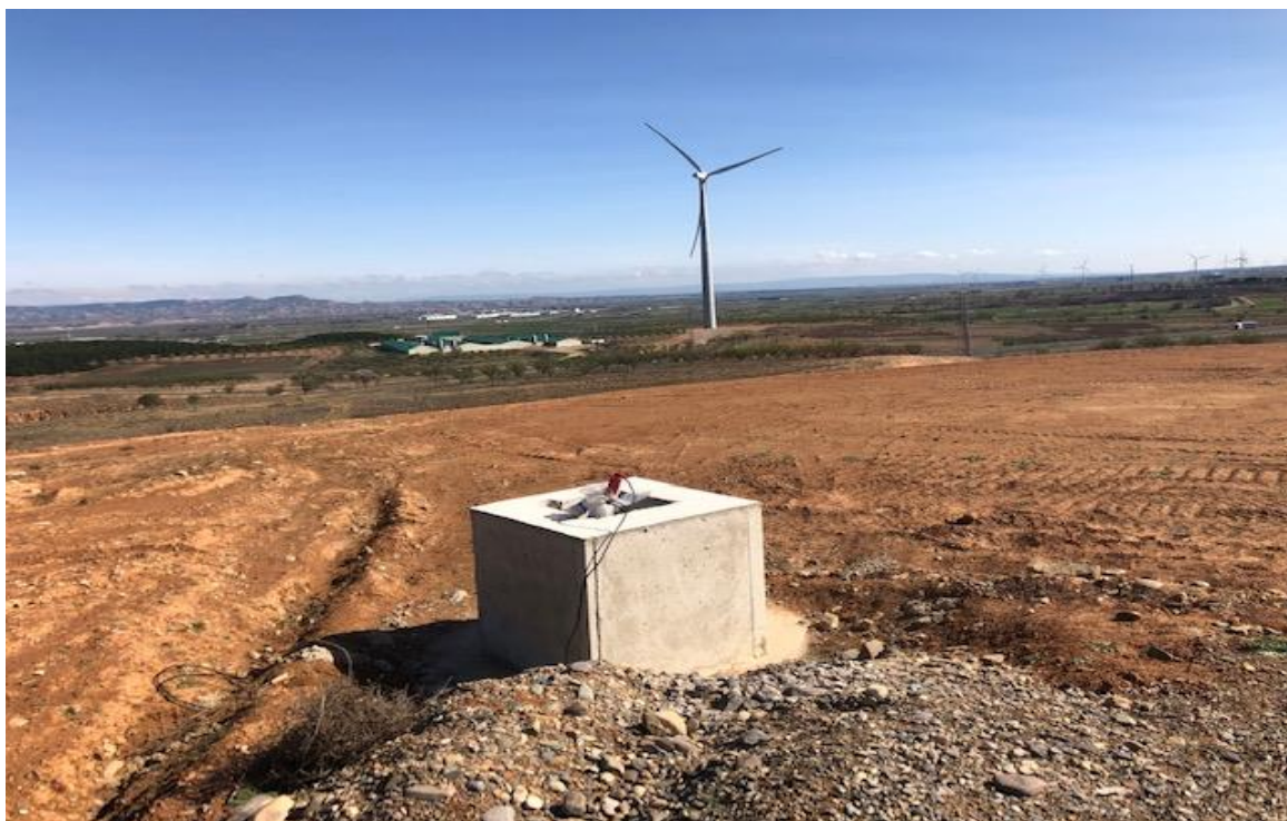
Imagen 5. Vista del encofrado del 3dobsever y tubos de energía y fibra.
