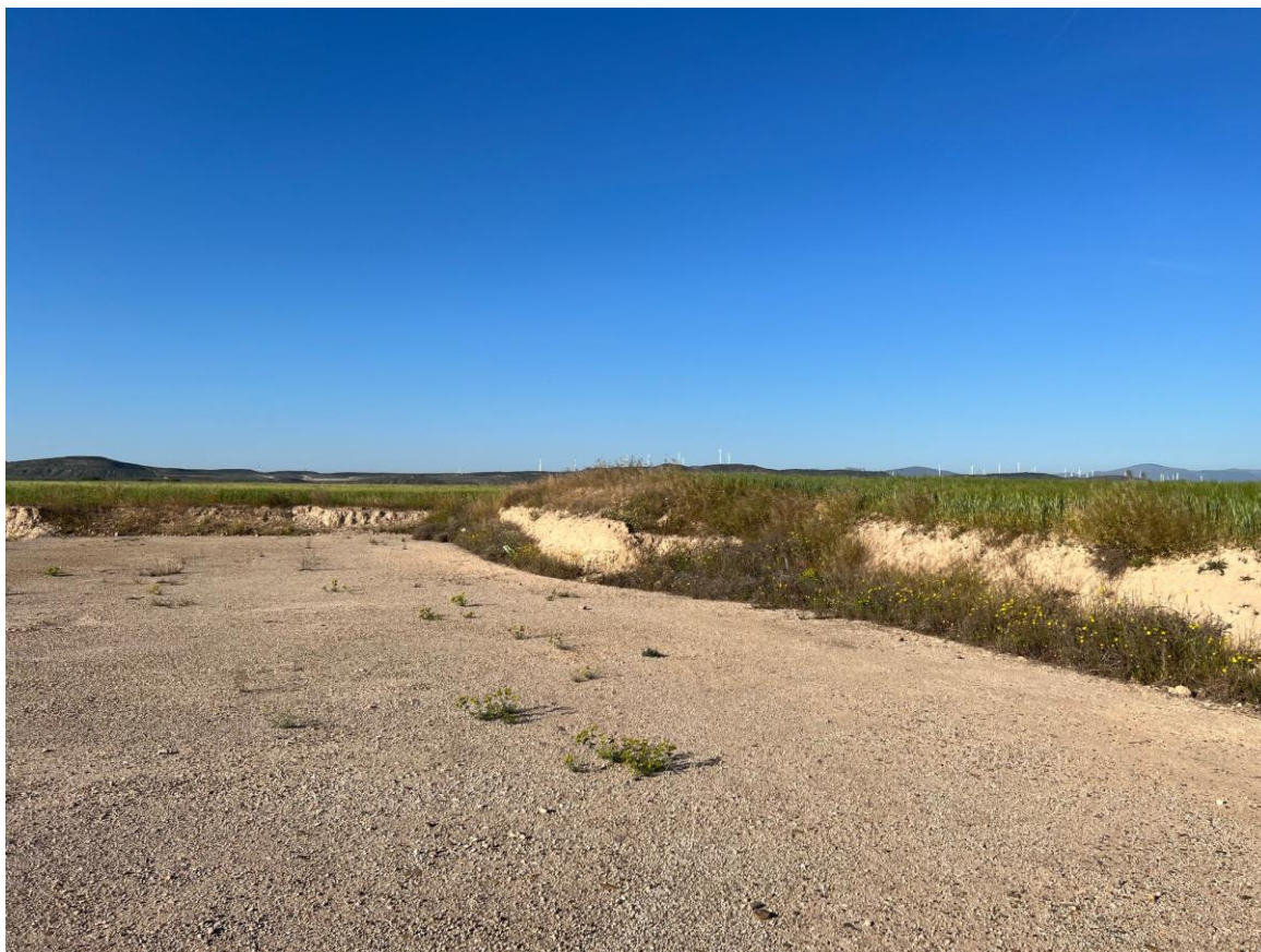
Imagen 12. Estado del talud anexo a la plataforma aerogenerador 7
