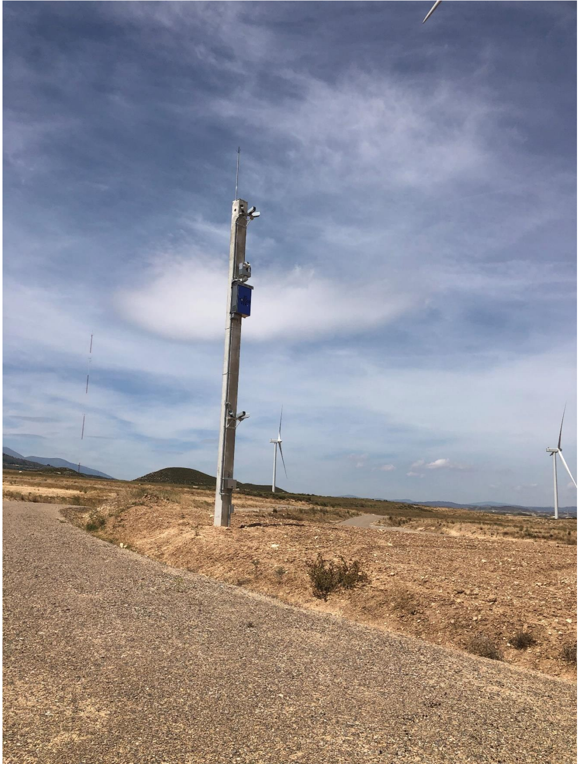
Imagen 7. Vista del 3dobsever 2 ya instalado.
