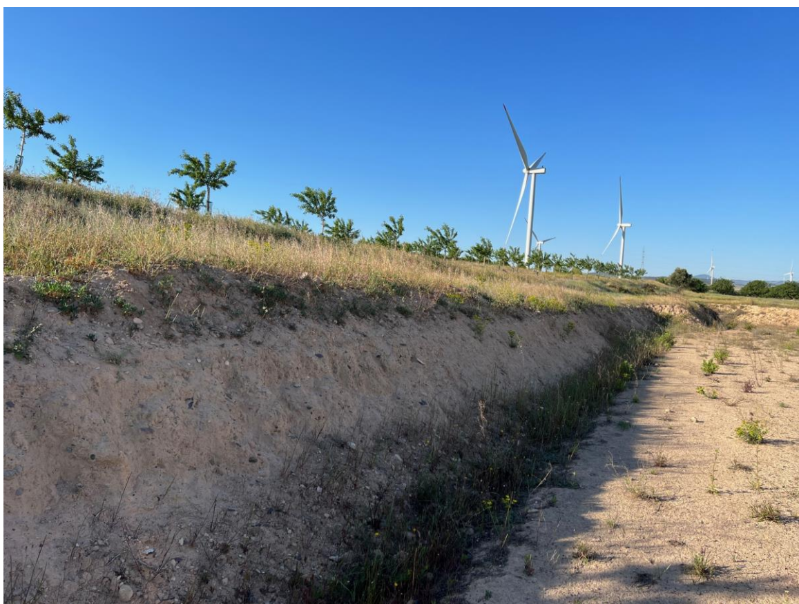
Imagen 13. Estado del talud anexo a la plataforma aerogenerador 4.
