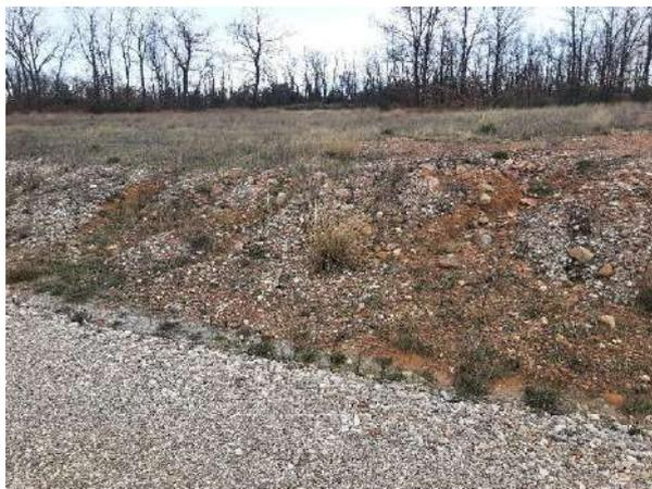
Las cárcavas de mayor tamaño se encuentran en la cara suroeste de la plataforma de dicho aerogenerador, junto al canal de drenaje. Como puede observarse a continuación, se han estabilizado y no presentan grandes diferencias con el cuatrimestre anterior.
