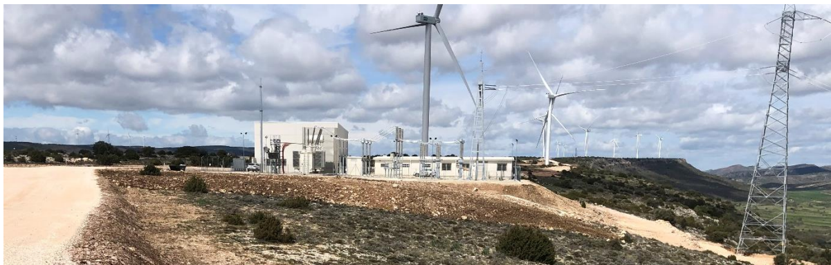
Figura 2: Vistas de la subestación
