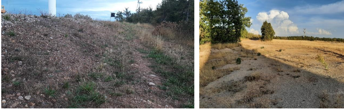
Talud sur de SP-02 (izquierda) y zona alta del talud norte de SP-04 (derecha).
