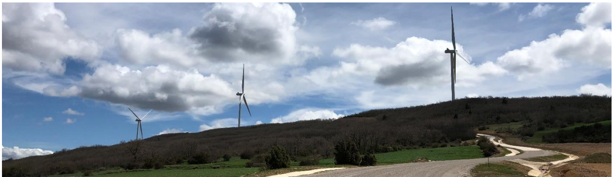
Figura 1: Vistas del parque eólico
