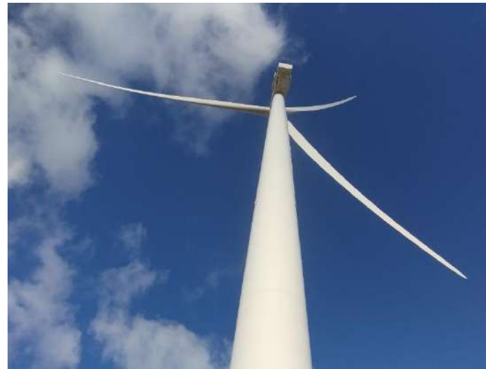
Fotografía 3: Barquillas de los aerogeneradores sin derrames de aceite
