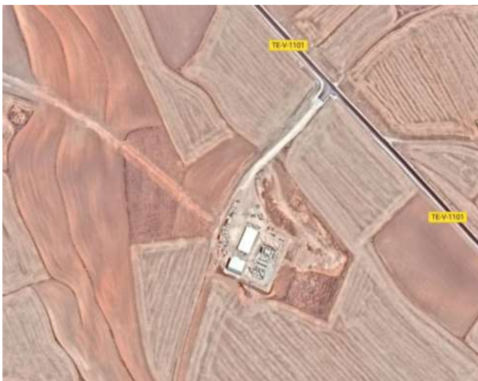
Figura 2: Subestación eléctrica sobre foto aérea
