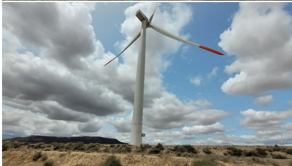
Fotografías 2 y 3: Barquillas de los aerogeneradores sin derrames de aceite. Pintado de palas.
