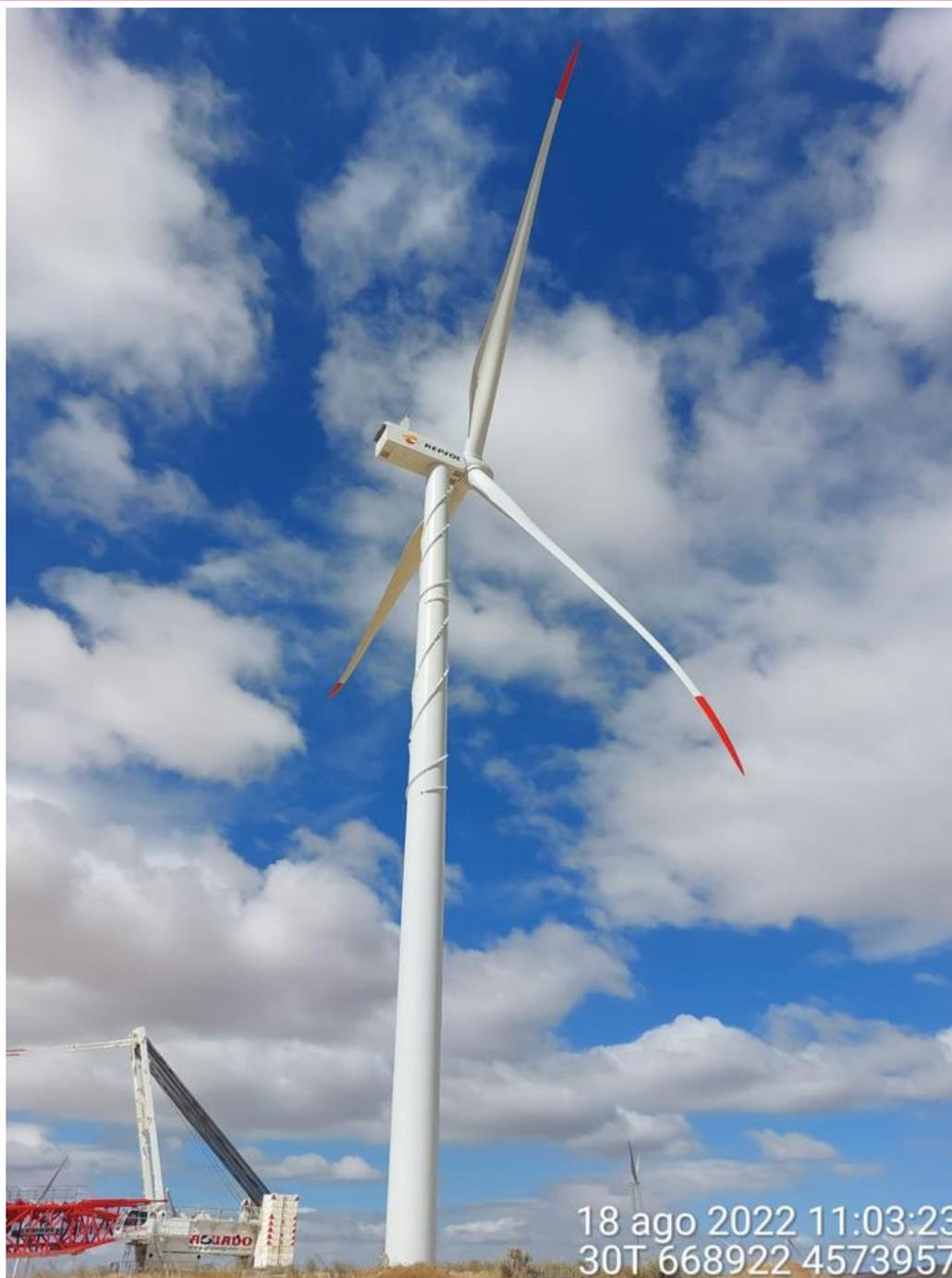
Imagen 2. Aerogenerador en fase de montaje.
