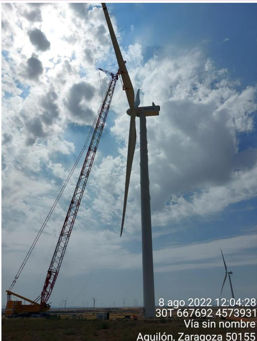
Imagen 3. Montaje aerogenerador.
