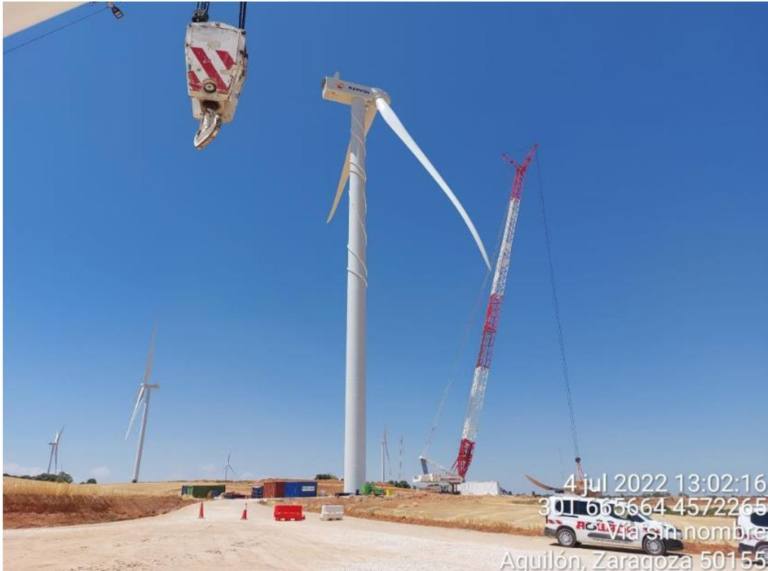
Ilustración 2. Montaje del aerogenerador SBII-06.
