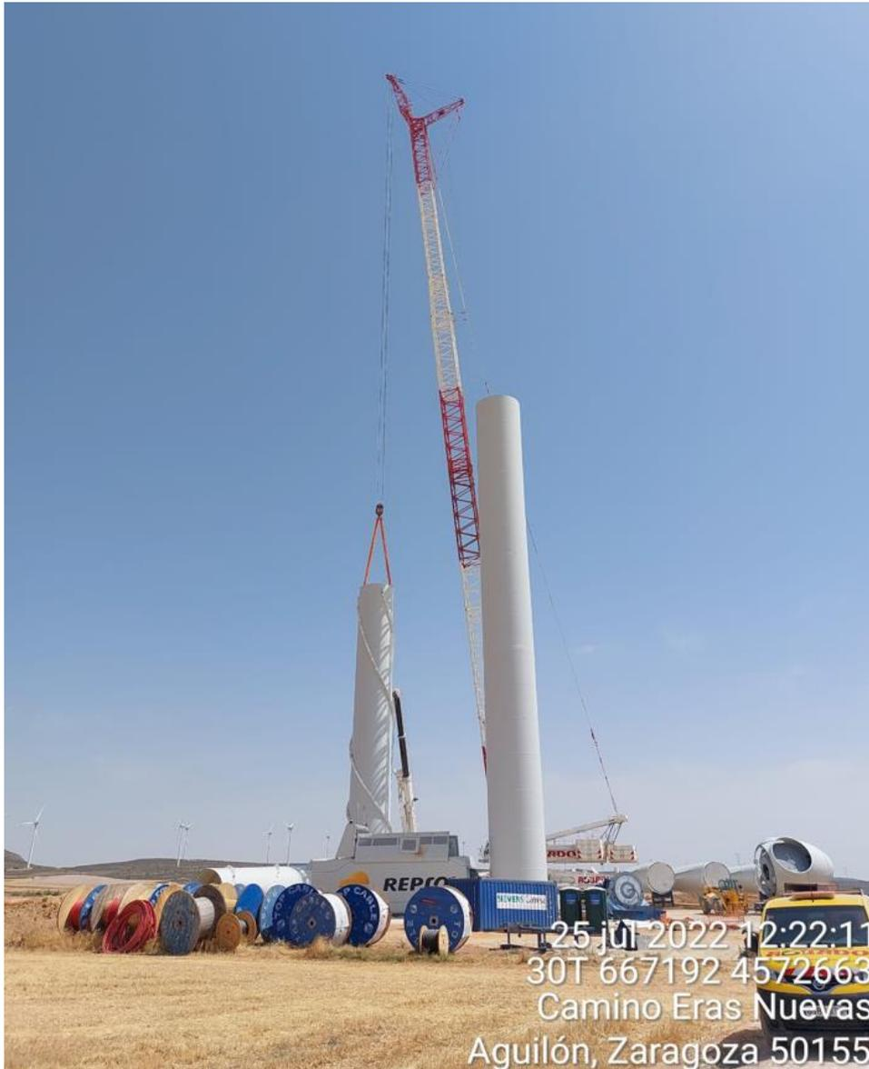
Imagen 2. Montaje del aerogenerador SB1-09
