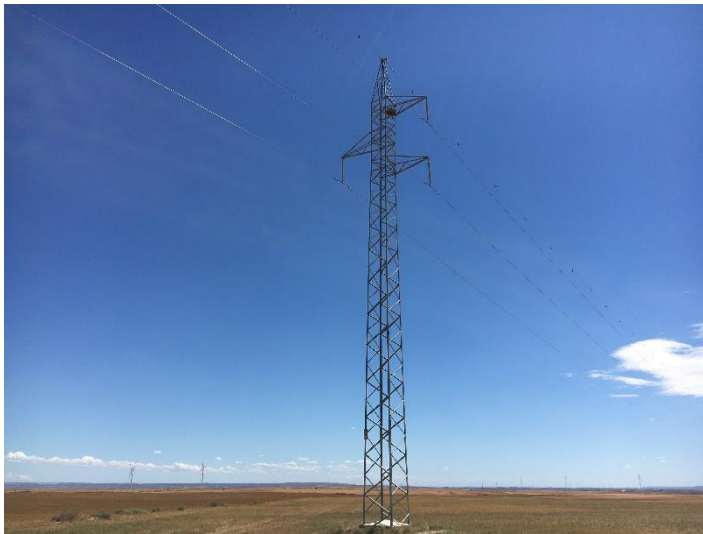
Fotos 17 a 20: Línea de evacuación con dispositivos salvapájaros
