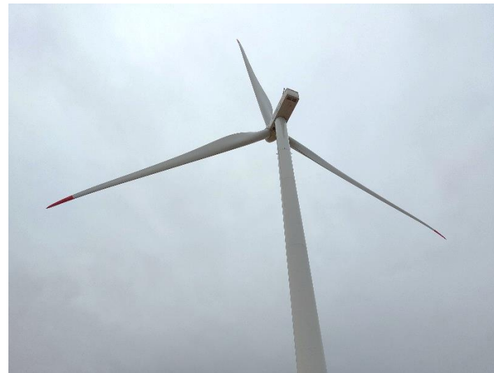
Fotos 7 y 8: Aerogeneradores con palas pintadas (medidas de innovación).
