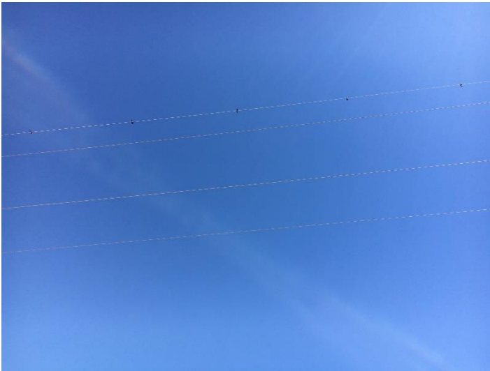
Fotos 23 y 24: Detalle de los dispositivos salvapájaros
