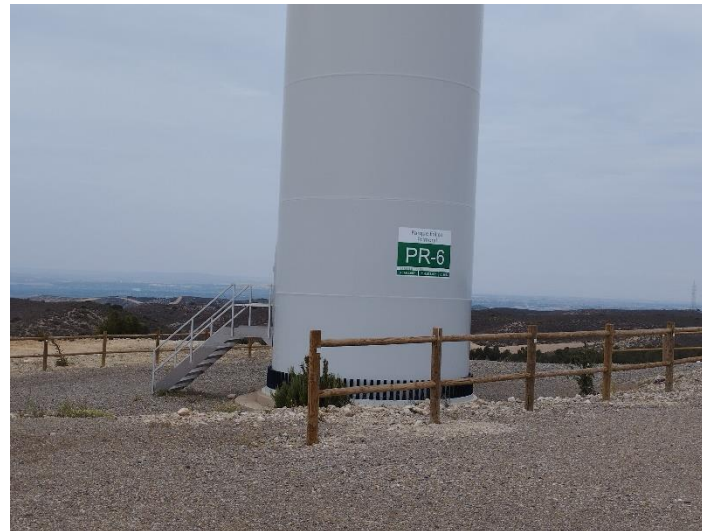
Fotografías 11 a 13: Señalización de las torres de los aerogeneradores
