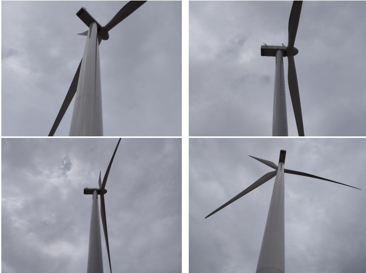
Fotografías 3 a 6: Barquillas de los aerogeneradores sin derrames de aceite
