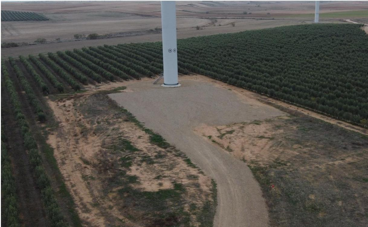
Foto nº4.: Plataforma del Aerogenerador PE-04.
