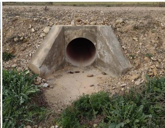
**Foto nº10.:** Drenaje (orientación norte) de vial de acceso PE-02.
