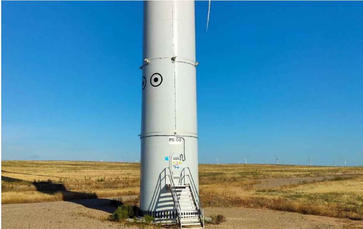
**Foto n°7.:** Dispositivo DTBird, y pintado "ojos de búho" en PE-03.
