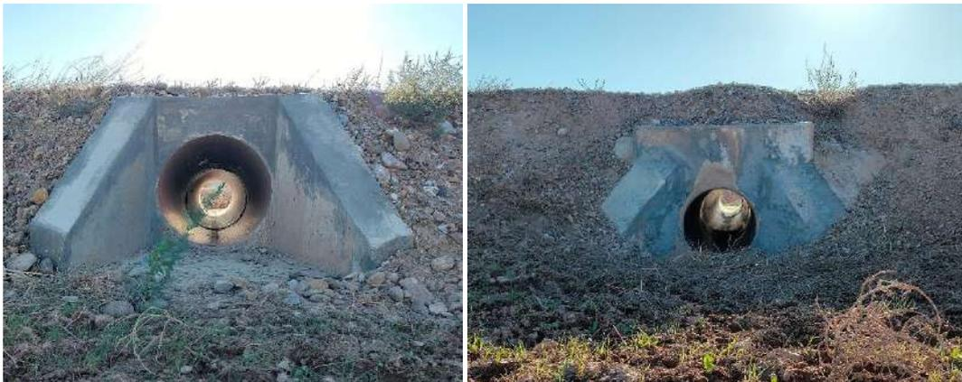
Foto nº10.: Drenaje (orientación sur) de vial de acceso PE-02.
